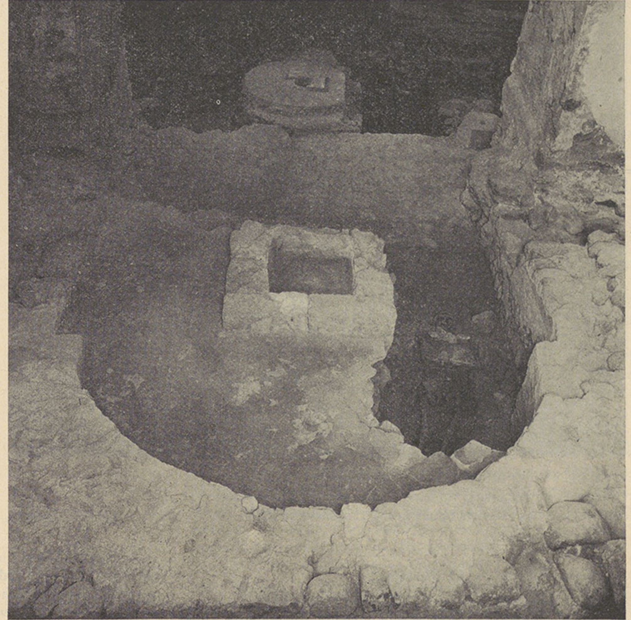
Blick von Osten her auf den Chor des zweiten Baues. Westlich von der halbrunden Apsis der Altarblock mit Hohlraum für die Aufnahme der Reliquien. Im Hintergrund das Schiff mit einem jüngern Taufsteinfundament.
