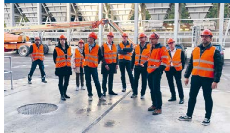
Der Gemeinderat besichtigt den Neubau der BAV Belag AG
