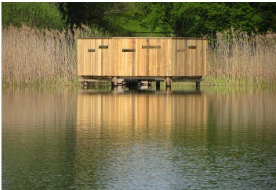
Abb. 37: Der Beobachtungssteg mit der Sichtschutzwand vom Wasser her. (Foto E. Ott)
