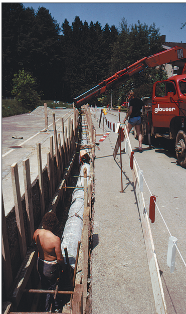
Abbildung 39 Bau der Verbindungsleitung ( \varnothing 400mm) zwischen den Reservoiren Guglen und Looren in der Weidstrasse.
