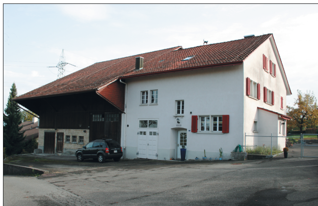
Abbildung 7 Das Bauernhaus der Familie Hotz (oberer Pfaffenstein) brannte 1942 mitsamt der Scheune ab, wurde aber im gleichen Stil als Mittertennhaus wieder aufgebaut. Es ist geplant, den ungenutzten Ökonomieteil durch einen Garageanbau zu ersetzen.
