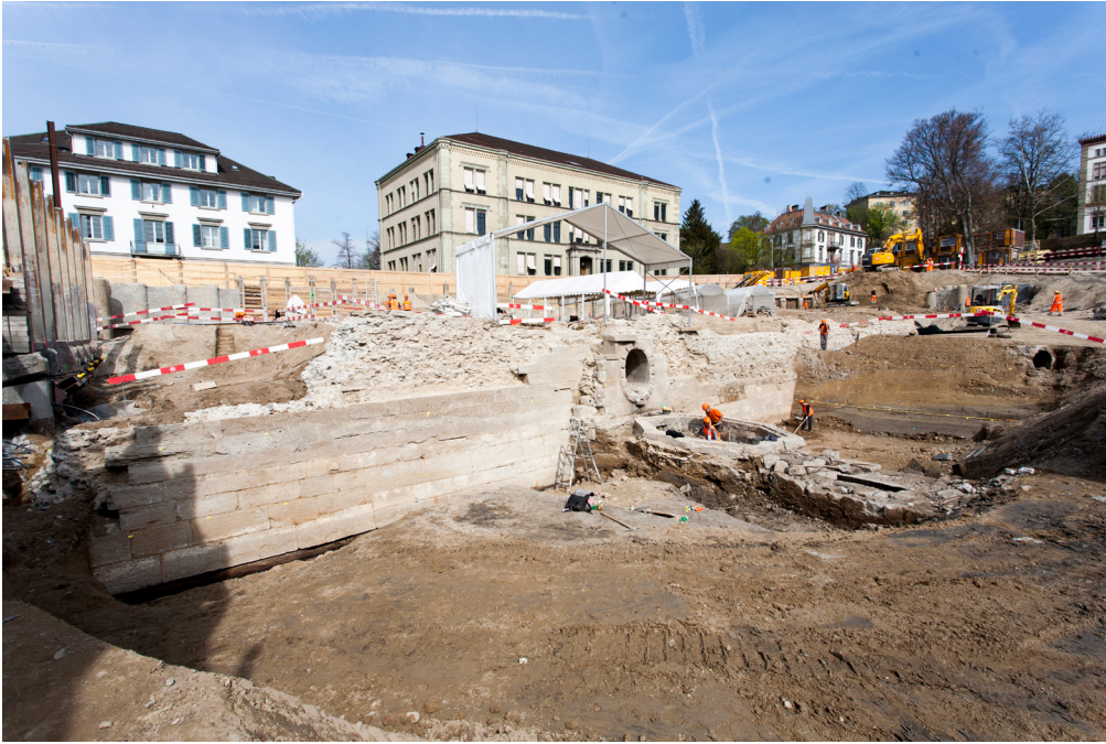
Abb. 122 Zürich-Kunsthhaus. Die freigelegte Escarpe. Blickrichtung Nord.
