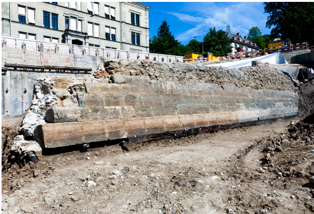
Abb. 124 Zürich-Kunsthaus. Die Eskarpe Richtung Rämibastion. Über den grossen, originalen Sandsteinquadern folgen kleinere Quader der Reparaturarbeiten von 1811. Die höheren Quaderlagen wurden bei der Schleifung 1833 entfernt. Blickrichtung Nord.
