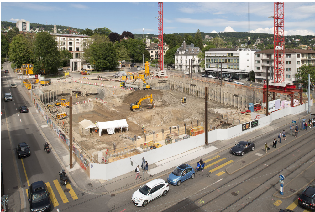
Abb. 13 Zürich-Kunsthhaus. Die Baugrube im Mai 2016. Erkennbar ist der unterschiedliche Fortschritt des Aushubs. Rechts im Bereich des ehemaligen Befestigungsgrabens sind die Bohrungen und Ausfachungen bereits weitgehend erfolgt.
