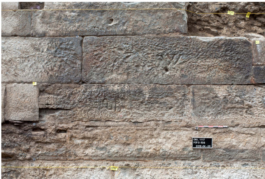
Abb. 125 Zürich-Kunsthaus. Detail des Originalmauerwerks der Eskarpe. Quader mit verschiedenen Steinmetzzeichen. Erkennbar sind der breite Randschlag sowie der mit dem Spitzmeissel oder Zweispitz gehauene Spiegel.
