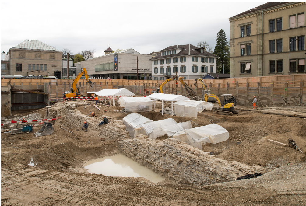
Abb. 12 Zürich-Kunsthhaus. Stand der Ausgrabung im April 2016. Sichtbar ist die Abbruchkante der Eskarpe; unter den hinteren Zelten werden die Befunde um die Wachhäuschen freigelegt.
