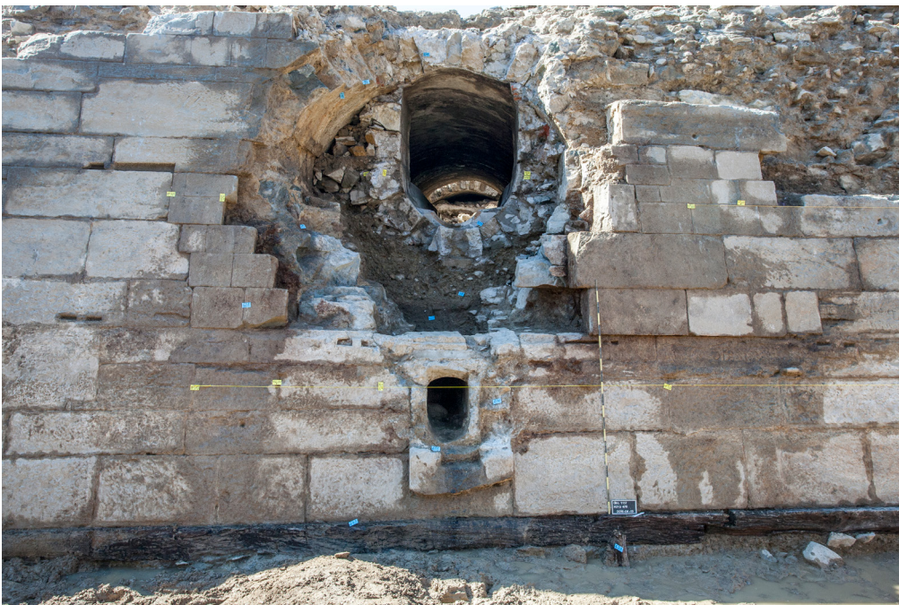
Abb. 131 Zürich-Kunsthhaus. Der freigelegte Wolfbachkanal. Hinten rechts die teilabgebrochene Eskarpe. Auffallend die ehemals in die Schüttungen reichenden Zungenmauern. Blickrichtung Ost.
