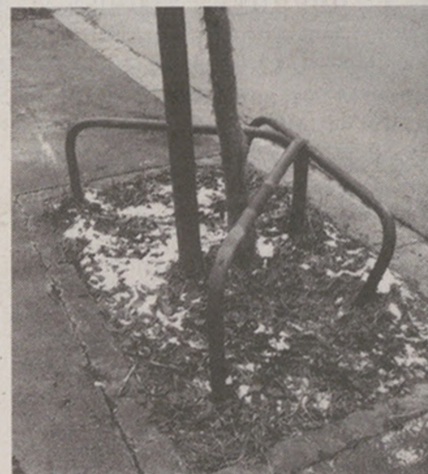
Improvisierter Baumschutz wie er in dieser oder ähnlicher Form in der Ackersteinstrasse anzutreffen ist. Dort wo nötig, werden die Baumgruben mit einem einheitlichen Baumschutz versehen, der die Bäume vor Stammverletzungen bewahren soll.
