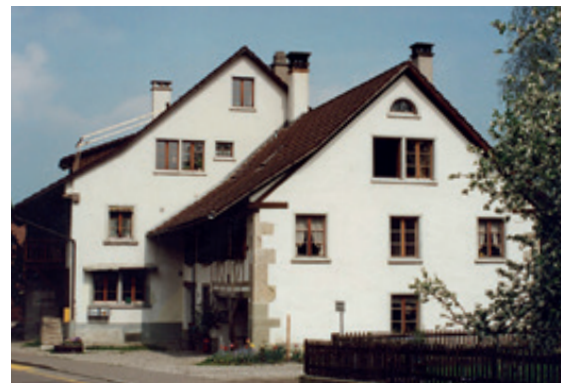
1978 vor und 1998 nach der Renovation aller Hausteile
