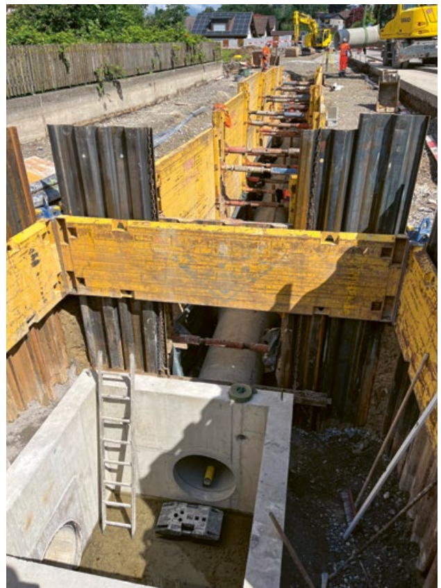
Ausbau der Abwasserentsorgung mit neuen Meteorwasserkanälen
