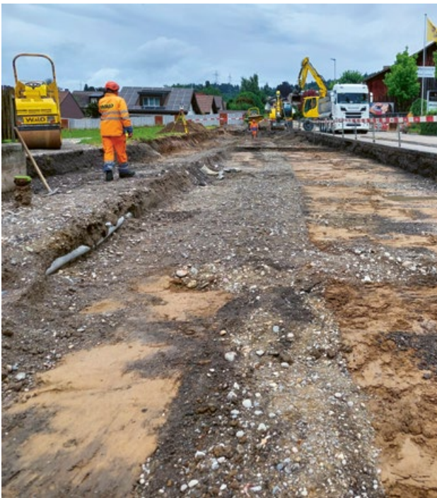
Abtragen der Kehrichtschlacke
