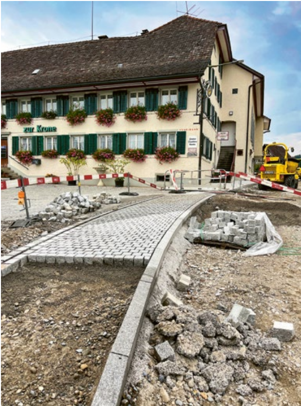
Pflasterung des neuen, lärmarmen Belags
