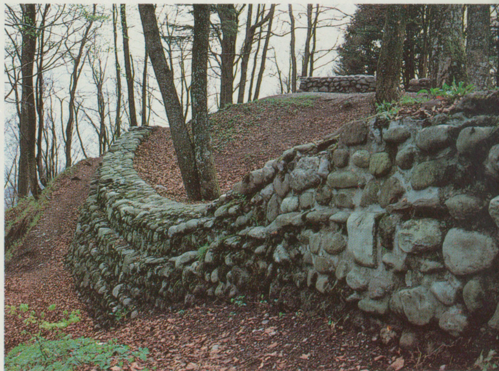
Schnabelburg. Die teilweise rekonstruierte Ringmauer und die Reste des Backofens im Hintergrund. Ansicht von Osten.
