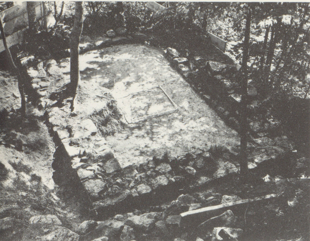
Sellenbüren. Fundament des ehemaligen Holzhauses auf dem östlichen Plateau. Grabung 1950/51.
