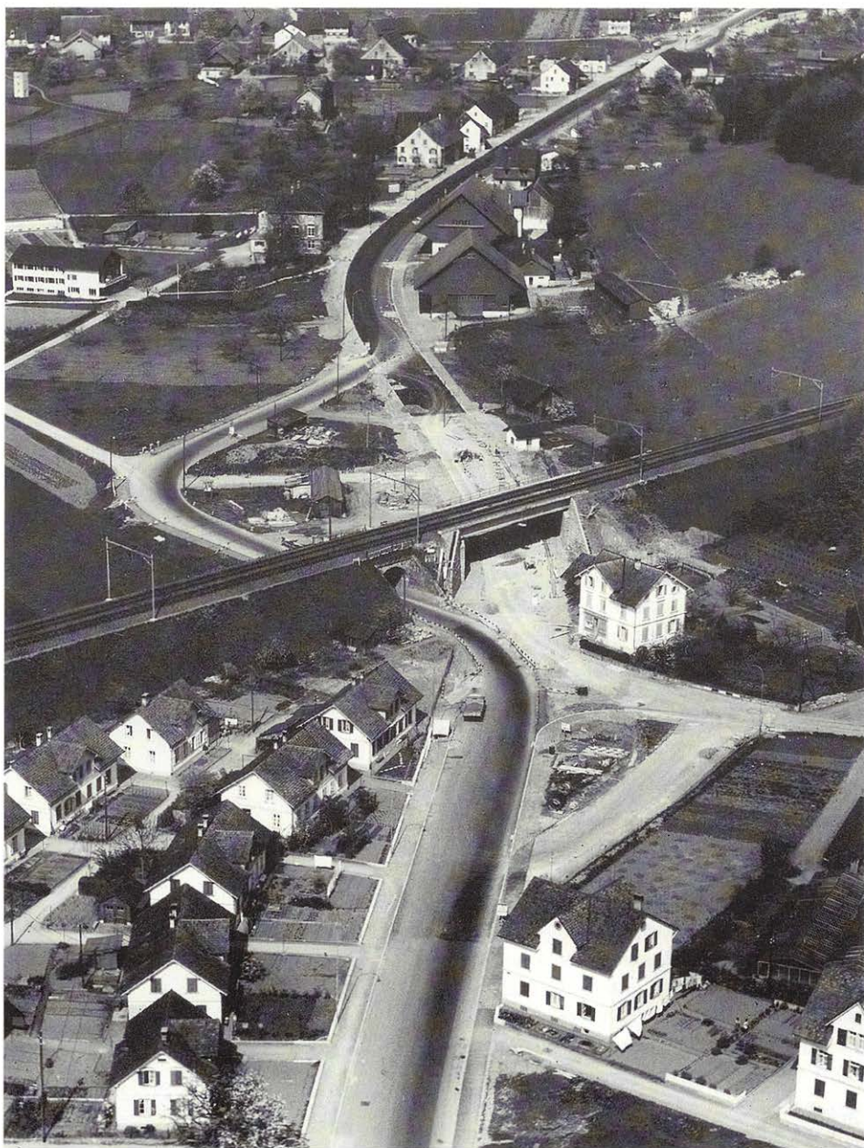
Im Zuge des Ausbaus der Zürichstrasse wurde 1954 die Bahnunterführung am Dorfausgang von Brüttsellen verbreitert und begradigt. Das alte Trasse ist noch gut sichtbar. Links vorne das Walder Dörfli,
