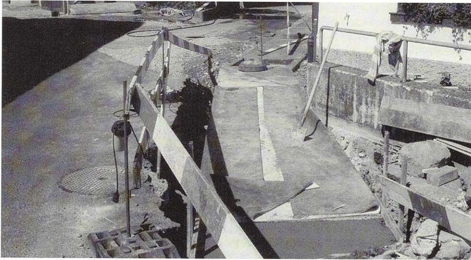
1997/98 wurde der eingedolte Dorfbach im Dorfzentrum von Wangen freigelegt, saniert und wieder zugedeckt. Auf dem Bild die Baustelle am Dorfplatz.
