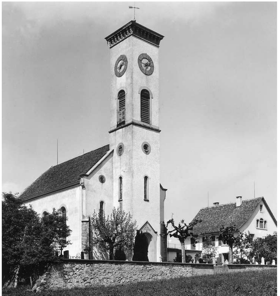
Reformierte Kirche Hütten, erbaut 1855–1856 mit staatlicher Unterstützung nach Plänen von Staatsbauinspektor Johann Caspar Wolff. Aufnahme von Max Weiss (geb. 1912), 1952. Hochbauamt Kanton Zürich, Photoarchiv.
