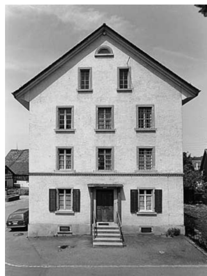
Ehemaliges Bezirksgefängnis in Andelfingen, erbaut 1854, wohl nach Plänen von Staatsbauinspektor Johann Caspar Wolff. Aufnahme von Kuno Gyga, 1983. Hochbauamt Kanton Zürich, Photoarchiv.
