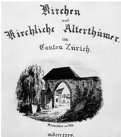
Ludwig Schulthess (1805–1844), 1832 bis 1836 Ingenieur-Adjunkt des Kantons Zürich. Pionier der ikonographischen Inventarisierung von historischen Baudenkmalern. Titelblatt der Mappe «Kirchen und kirchliche Alterthümer im Canton Zürich», mit Vedute des Klosters von Töss, 1835. ZBZ, Graph. Slg., PAS II 106.
