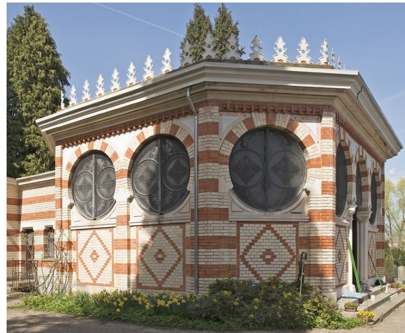
Baudenkmal: Abdankungshalle im Friedhof Unterer Friesenberg (Bild: BAZ_004086, Juliet Haller)
