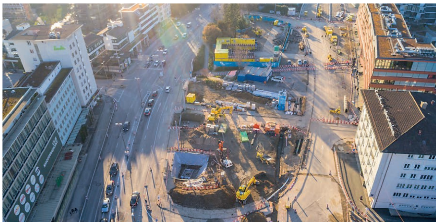
Der Stadtplatz Schlieren wird im Sommer 2018 zur Intensivbaustelle
