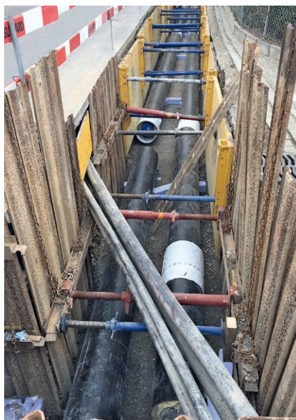
Fernwärmeleitungen werden in der Au- strasse–Föhrewaldliweg verlegt
