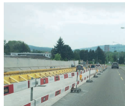
Die Autobahnbrücke Fahrweidstrasse wird vom Astra instand gestellt
