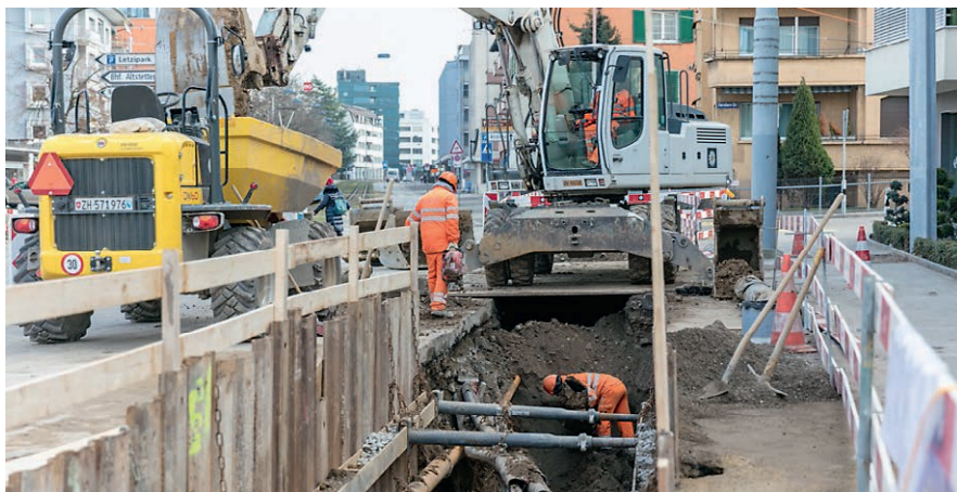
Der Bau der Werkleitungen ist ein wichtiger Bestandteil der Arbeiten.
