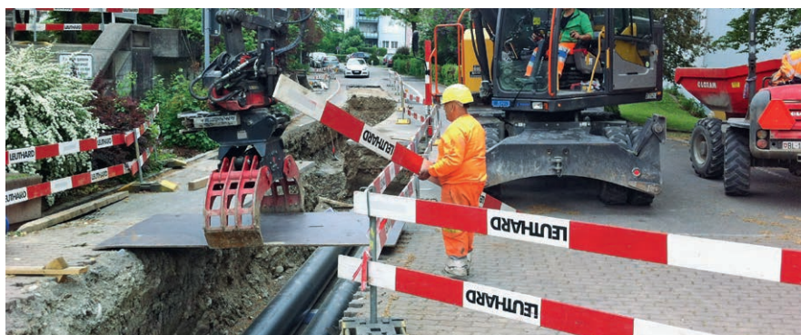
Fernwärmeleitungen werden in der Austrasse–Föhrewäldliweg verlegt
