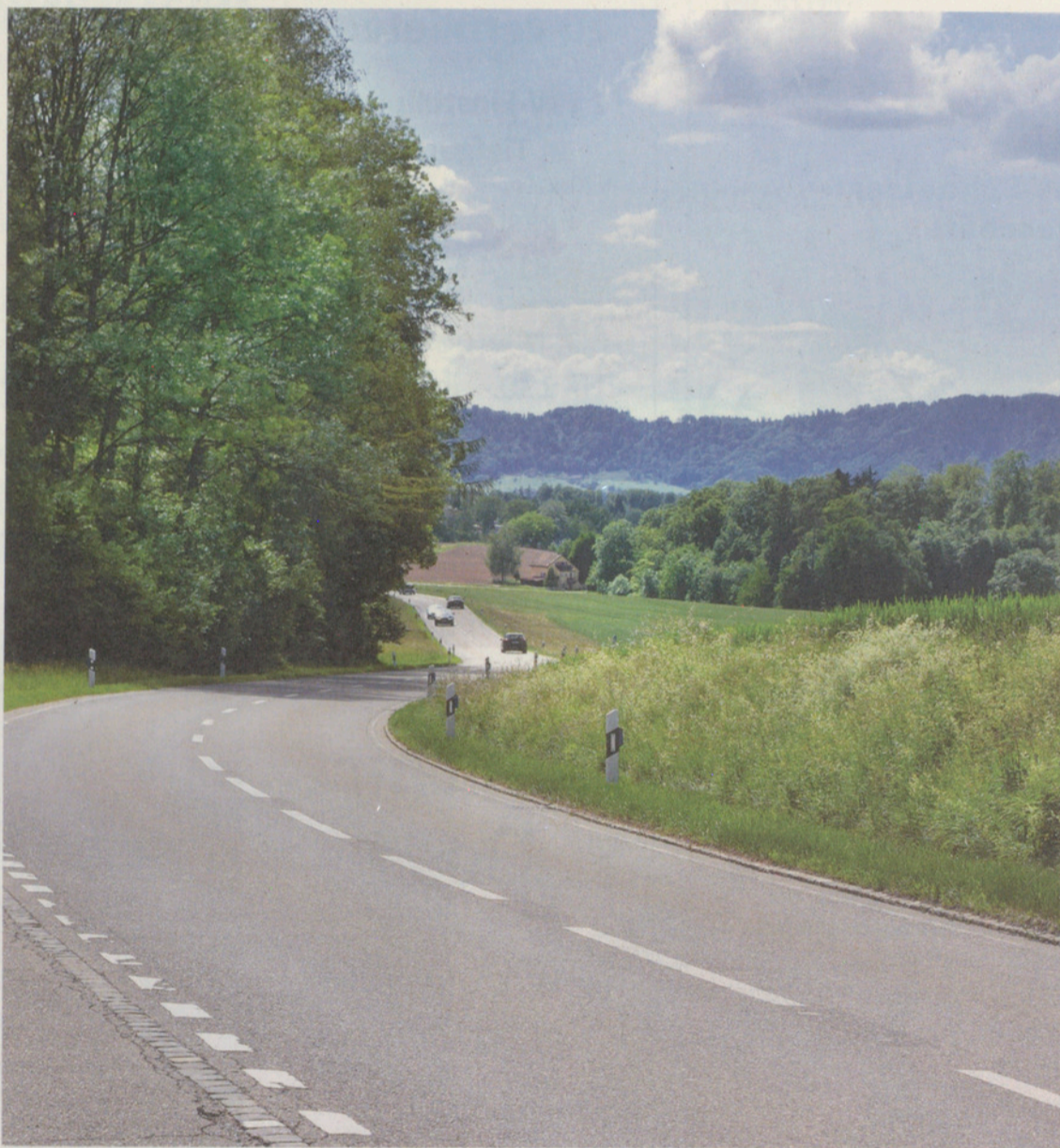
Bald soll auf dieser Strecke zwischen Zollikerberg und Binz ein Bus verkehren.
