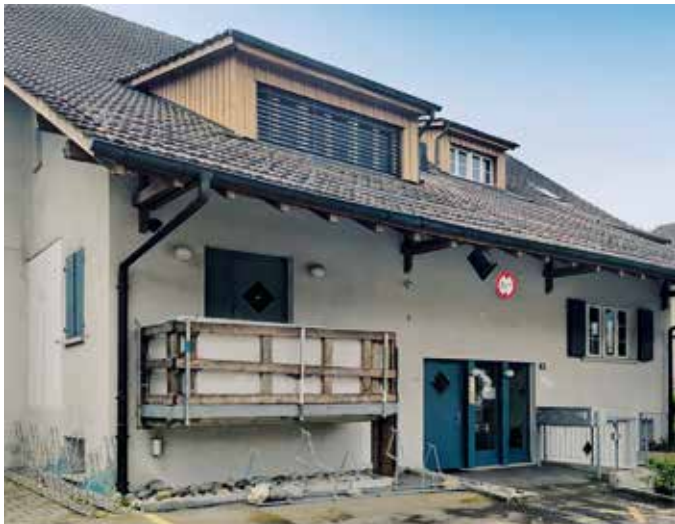
Bis im Juli 2025 wurde das Gebäude in Gotzenwil als Schulhaus genutzt, nun werden darin Kinder betreut. (Foto: David Herter)
