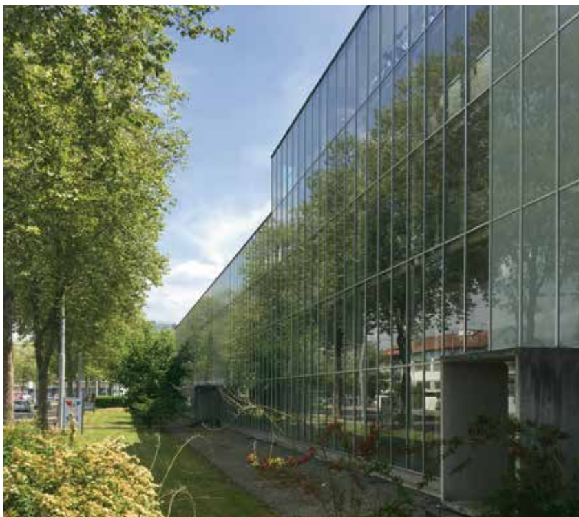
Verglaste Wände schirmen die langgestreckten, gemauerten Wohnblöcke gegen den Verkehrslärm der Zürcherstrasse ab, aufgenommen 2017
