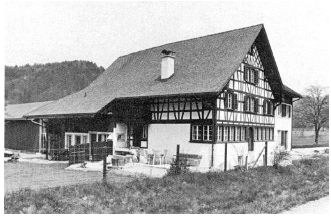
Zell. Untere Rüti. Bauernhaus Vers. Nr. 151. Nach dem Umbau 1977.
