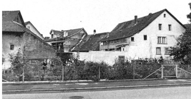
Bülach. Stadtmauer im Bereich Brunngrasse 14. Oben: Aquarell von L. Schulthess, 1839. (Original in ZB, Graph. Smlg.); Mitte: Vor der Konservierung und Ergänzung 1977; unten: nach der Konservierung und Ergänzung 1977.
