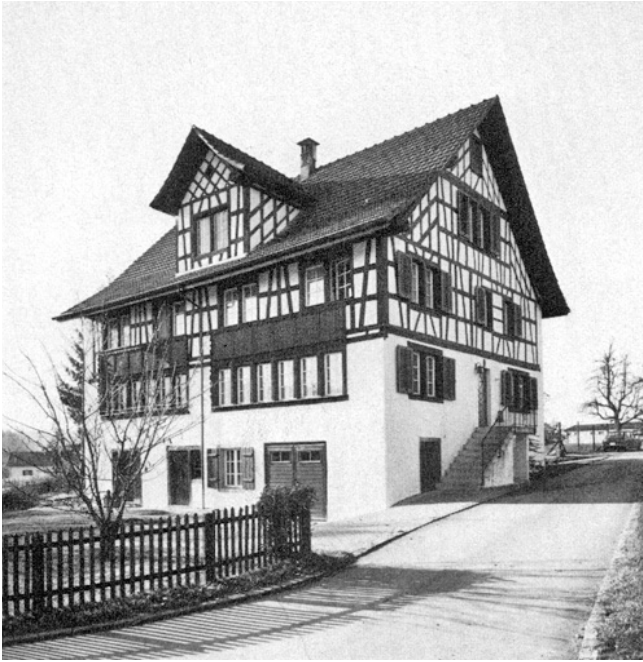
Richterswil. Grünfeld. Ehemaliges Bauernwohnhaus Vers. Nr. 759/760. Nach der Aussenrenovation 1977.
