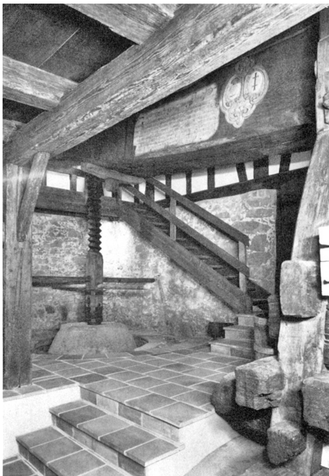
Thalwil. Alte Landstrasse 100. Trotte «An der Strass» (Vers. Nr. 546). Trottraum im Erdgeschoss. Nach der Restaurierung 1976/77.
