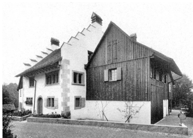
Regensdorf. Altburg. Ehemaliges Vogthaus (Vers. Nr. 9). Nach der Restaurierung 1976/77.
