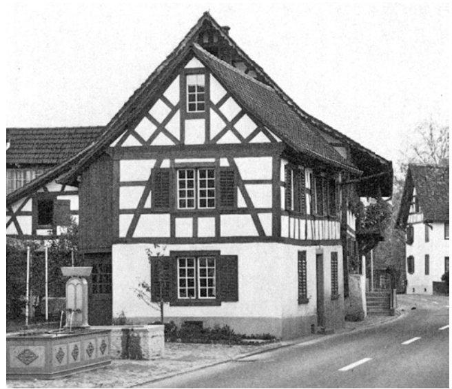
Dachsen. Dorfstrasse. Wohnhaus Vers. Nr. 19. Nach der Renovation von 1976/77.
