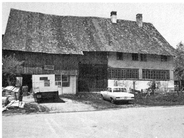
Opfikon-Glattbrugg. Bassersdorferstrasse 9. Ehemaliges Bauernhaus «Gsellhus», abgebrochen 1978.
