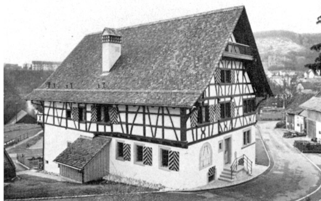
Eglisau. Weiherbach. Weierbachhaus. Ansicht von Norden. Nach der Restaurierung 1976/77.
