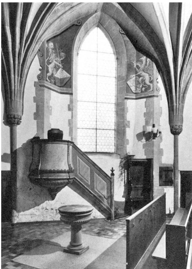
Greifensee. Reformierte Kirche. Inneres. Vor der Restaurierung 1977/78.
