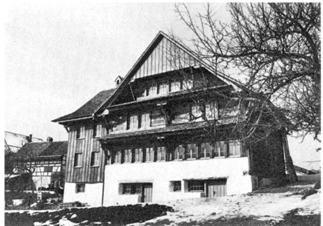
Turbenthal. Chäfer. Ehemaliges Bauernhaus Vers. Nr. 947. Nach der Restaurierung 1977/78.
