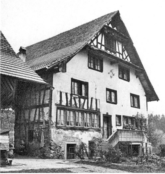
Hirzel. Untere Siten. Bauernwohnhaus Vers. Nr. 33. Vor der Aussenrenovation 1977.
