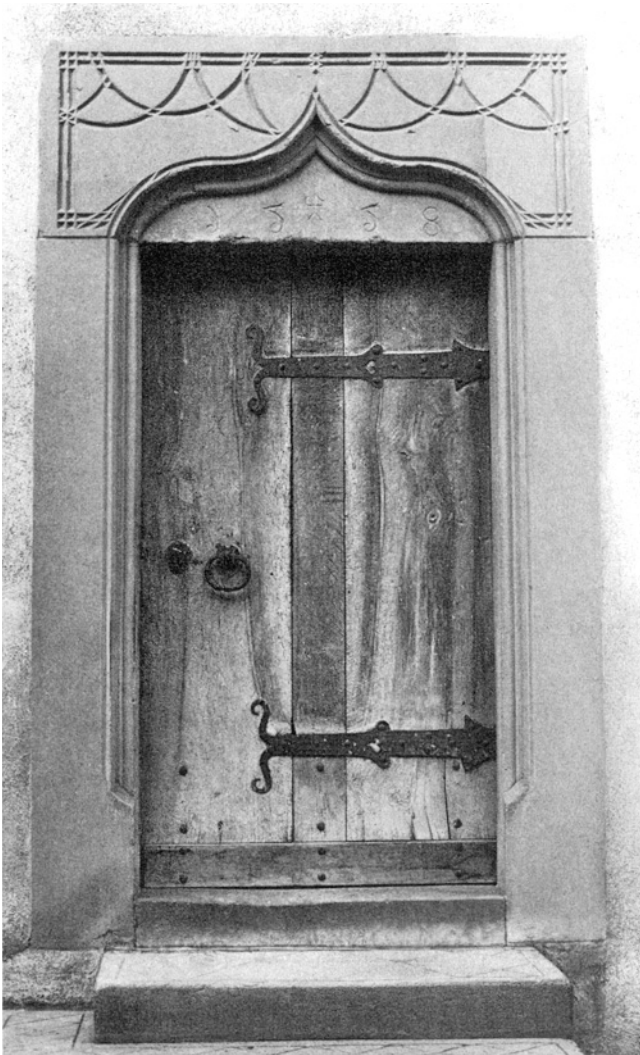
Berg a. I. Haus «Kloster». Hausteil Vers. Nr. 63a Spätgotisches Portal von 1558.
