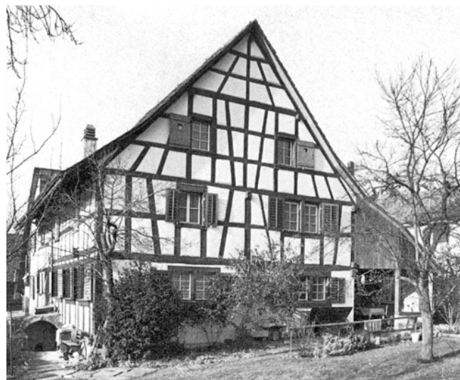
Glattfelden. Grünheinrichweg. Ehemaliges Bauernhaus Vers. Nr. 874. Nach der Aussenrenovation 1977.
