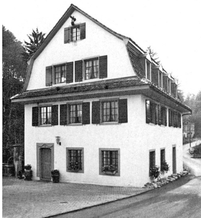
Bäretswil. Kemptertobel. Ehemalige Mühle (Hanfreibe). Nach der Renovation 1977/78.
