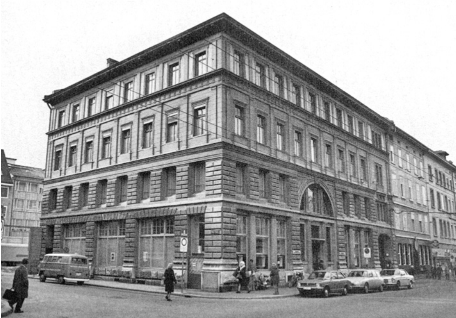
Altstadt. Stadthausstrasse/Ecke Münzgasse. Kantonalbankgebäude. 1977 abgebrochen.
