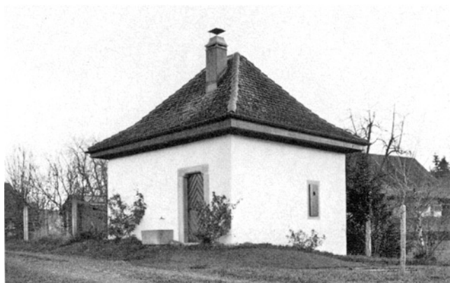
Horgen. Hinterklausen. Ehemaliges Schützenhaus Vers. Nr. 957. Nach dem Ausbau 1978.
