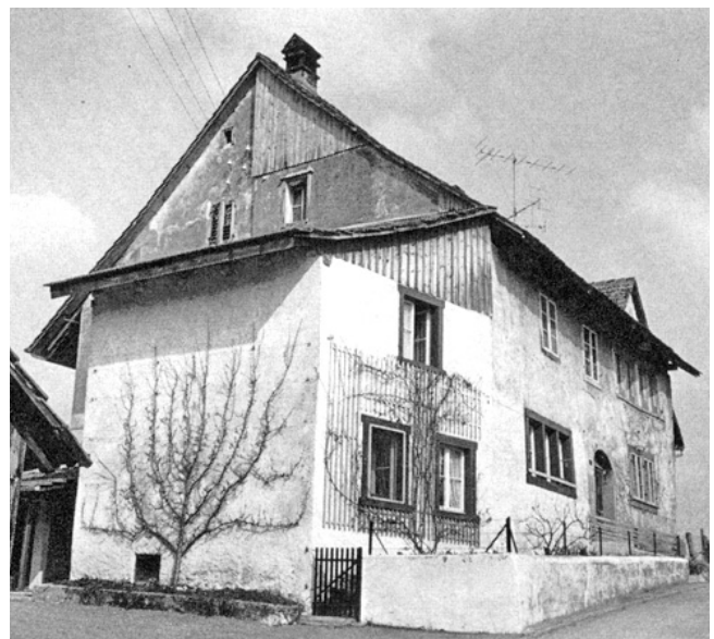
Regensdorf. Altburg. Ehemaliges Vogthaus (Vers. Nr. 9). Vor der Restaurierung 1976/77.
