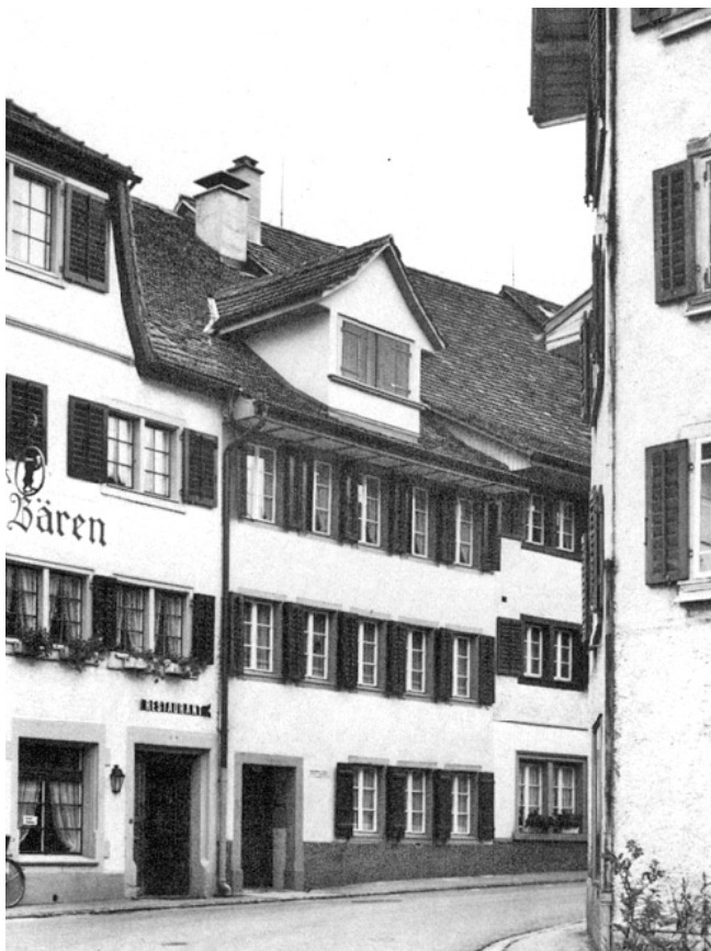
Grüningen. Städtli. Wohnhaus Vers. Nr. 850. Nach der Aussenrenovation 1978.
