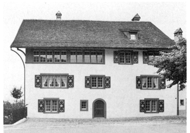
Regensberg. Oberburg. Amtshaus. Nach der Restaurierung 1977/78.
