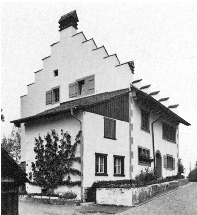
Regensdorf. Altburg. Ehemaliges Vogthaus (Vers. Nr. 9). Nach der Restaurierung 1976/77.
