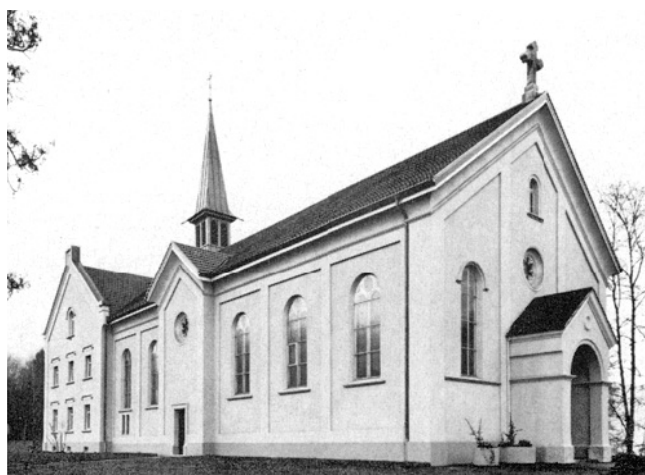
Pfungen. Katholische Kirche. Nach der Renovation 1978.
