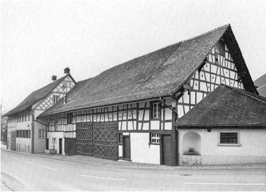
Wülflingen. Wieshofstrasse 104. Weispimühle. Ökonomiegebäude nach der Renovation 1978.
