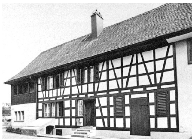
Kleinandelfingen. Hinterhofstrasse. Ehemaliges Doppelbauernhaus Vers. Nr. 428. Nach der Aussenrenovation 1977.
