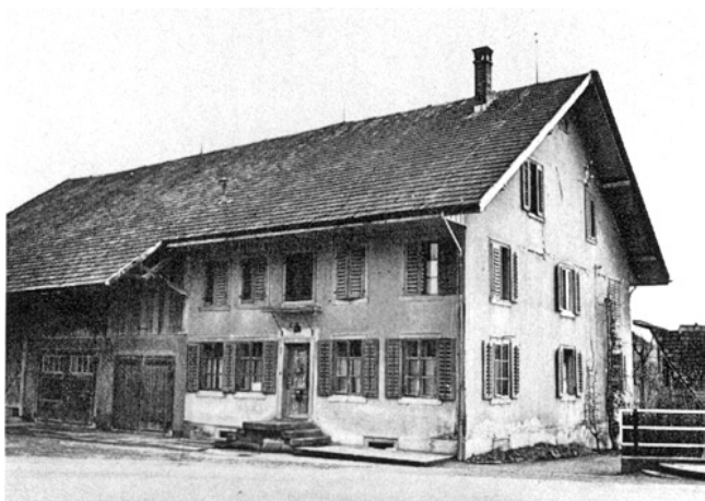
Maschwanden. Hauptstrasse. Bauernhaus Vers. Nr. 92. 1977 abgebrochen (zu Seite 102).
