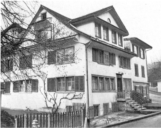
Wald, Jonastrasse 4, 6. Wohnhäuser Vers. Nr. 1497/1498. 1977 abgebrochen.
