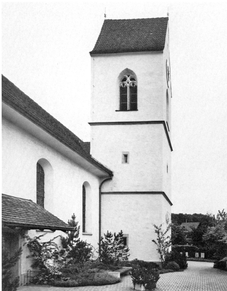
Elsau. Reformierte Kirche. Nordfasade mit Turm. Nach der Restaurierung 1977.
