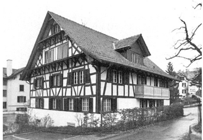
Wald, Kanzleiweg 2, 4/Plattenstrasse 12. Ehemaliges Doppelbauernhaus Vers. Nr. 1736/1776. Nach der Renovation 1976/77.
