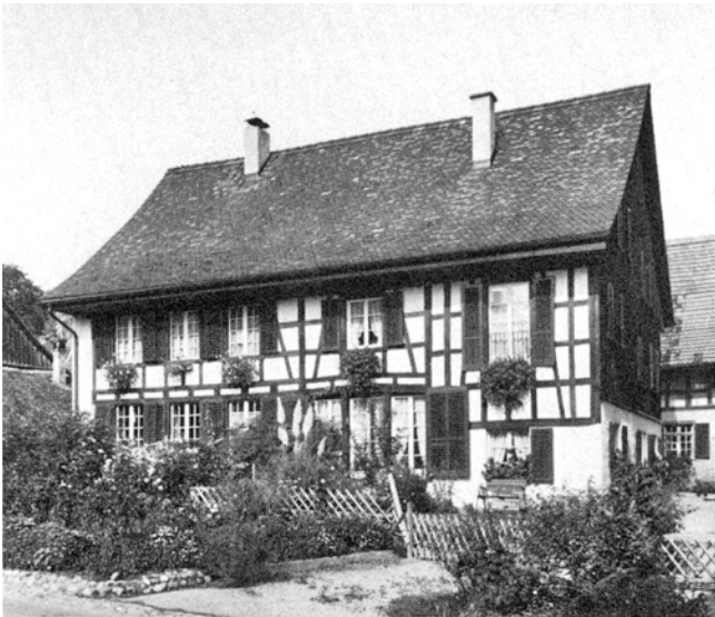
Oberstammheim. Im Höfli. Ehemaliges Bauernhaus Vers. Nr. 246/488. Nach der Renovation 1977.
