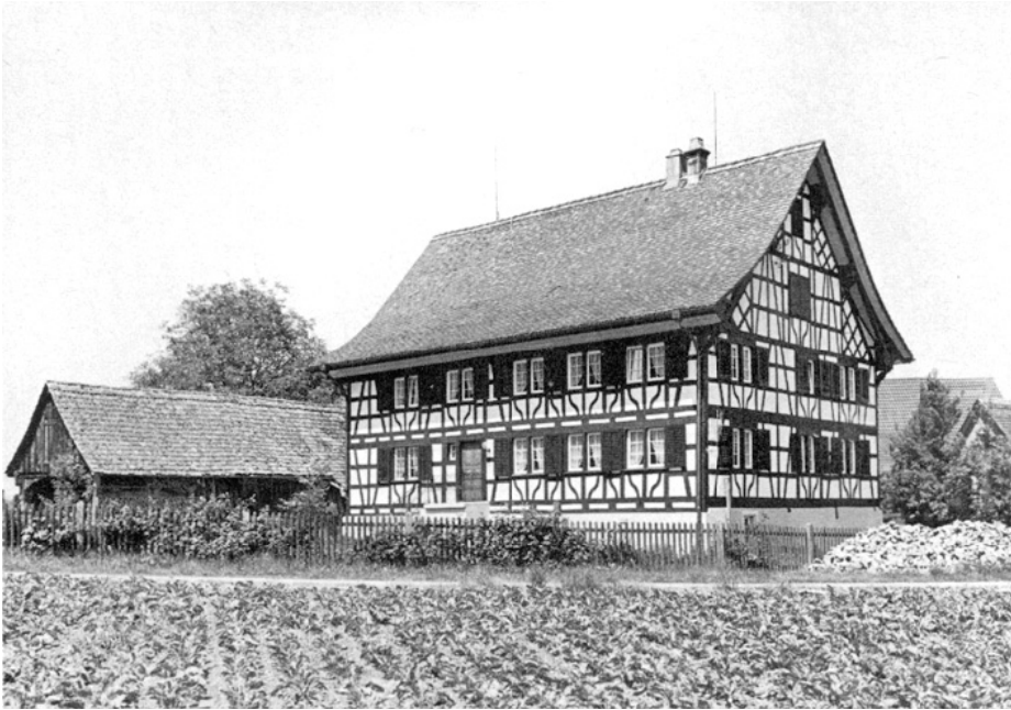
Waltalingen. Rietmühle. Mühle-Wohnhaus Vers. Nr. 87. Nach der Restaurierung 1977/78 (zu S. 221).
