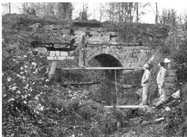
Flaach. Schollenberg. Alte Tuffsteinbrücke. Während der Restaurierung 1977/78.
