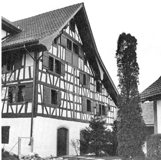
Wädenswil. Unterort. Ehemaliges Bauernwohnhaus Vers. Nr. 1747. Nach der Aussenrenovation 1977/78.
