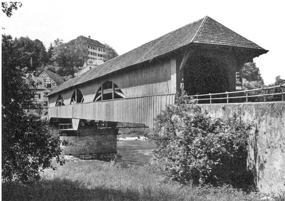
Andelfingen. Gedekte Thurbrücke. Vor dem Anbau eines Fussgängerstegs 1978.
