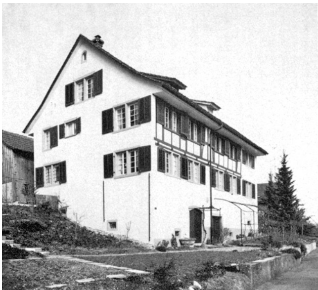
Stäfa. Uerikon. Alte Landstrasse 31/33. Ehemaliges Doppelweingebäude. Vers. Nr. 13/14. Nach der Renovation des Hausteils Vers. Nr. 13.
