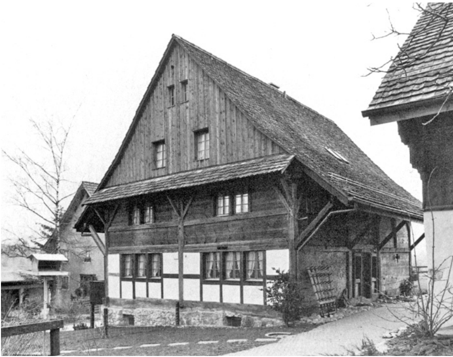
Mettmenstetten. Herferswil. Doppelwohnhaus Vers. Nr. 56/S7. Nach der Renovation 1976/77.
