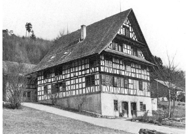
Hausen a. A. Husertal. Ehemaliges Bauernwohnhaus Vers. Nr. 410 mit Ökonomiegebäude. Nach den Renovationsarbeiten 1971–1977.
