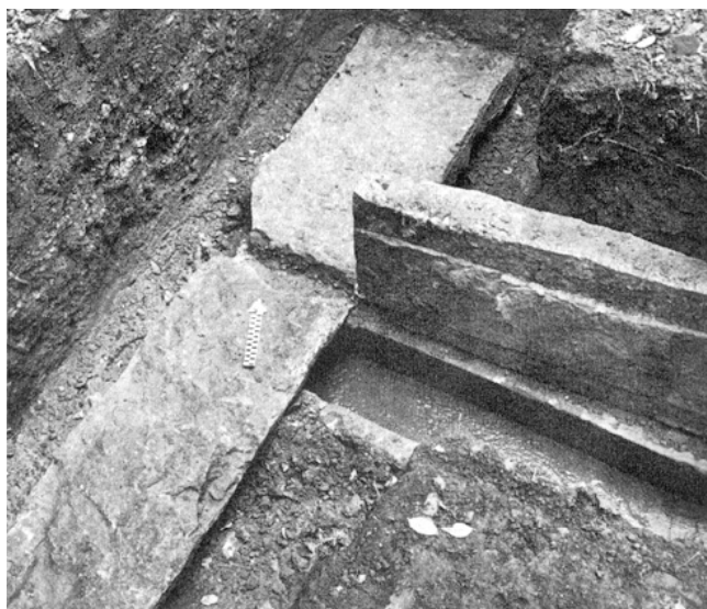
Altstadt, Hirschengraben, Obmannamt. Archäologische Untersuchung 1978/79. Freigelegte Drainagen.
