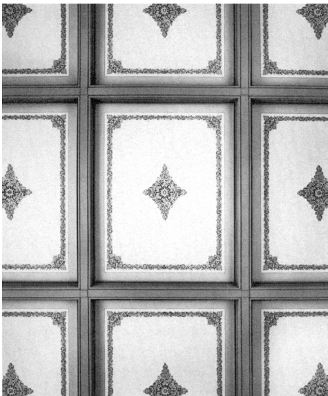
Töss. Reformierte Kirche. Nach der Restaurierung 1976/77. Dekkendetail (zu Seite 255).
