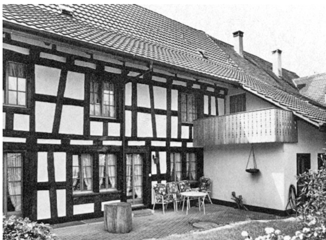
Rafz. Christengasse. Reihenhaus Vers. Nr. 547. Rückseite. Nach der Aussenrenovation 1977/78.
