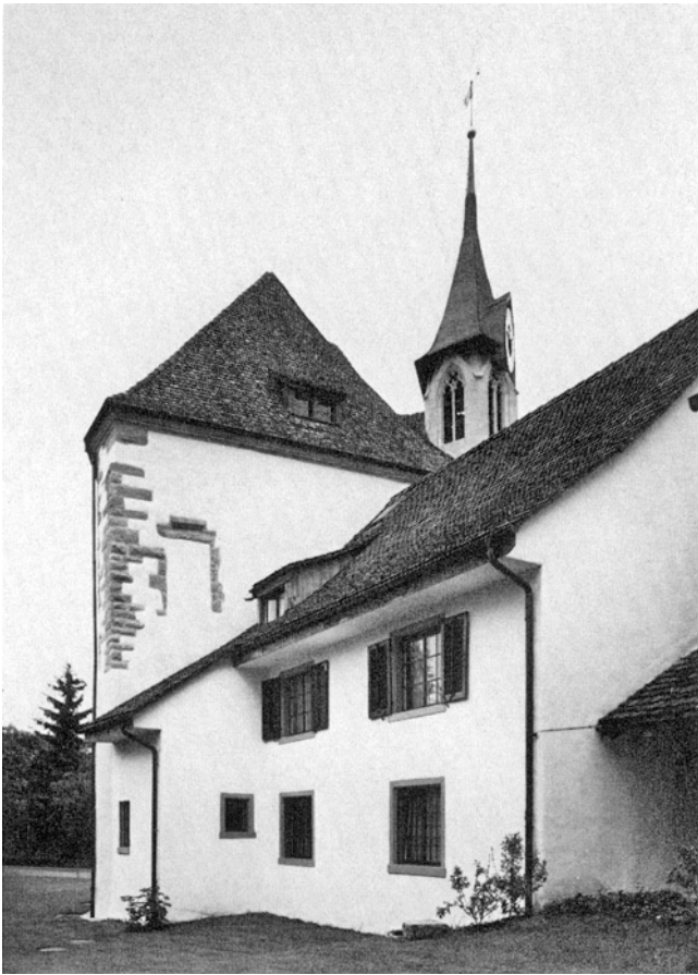
Greifensee. Reformierte Kirche. Nordwestseite. Nach der Restaurierung 1977/78.
