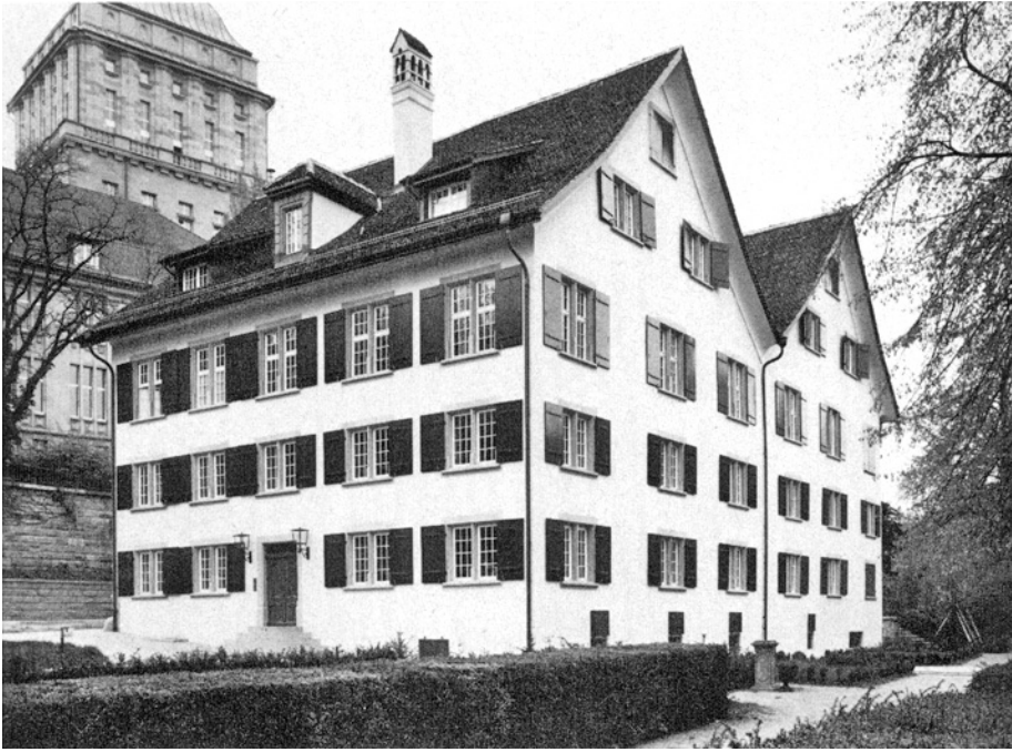
Künstlergasse 15/Sempersteig 3 Stockargut. Herrschaftshaus. Nach der Restaurierung 1977/79.
