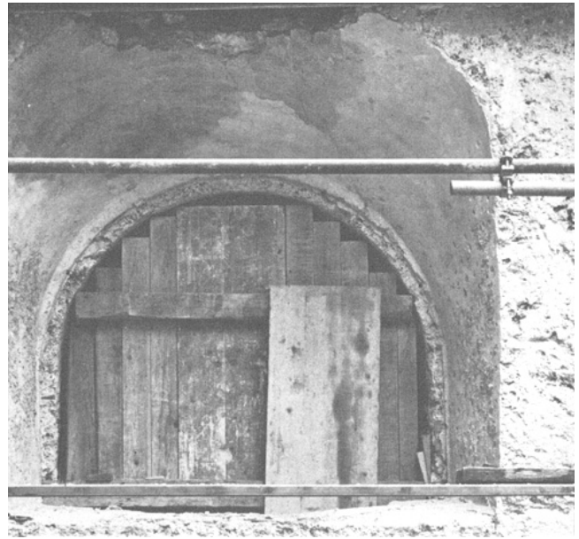
Rüti. Ehemalige. Klosterkirche. Archäologische Untersuchung 1980/81. Nördliche Seitenkapelle. Ostfassade. Ursprüngliche Fensteröffnung nach der Freilegung.
