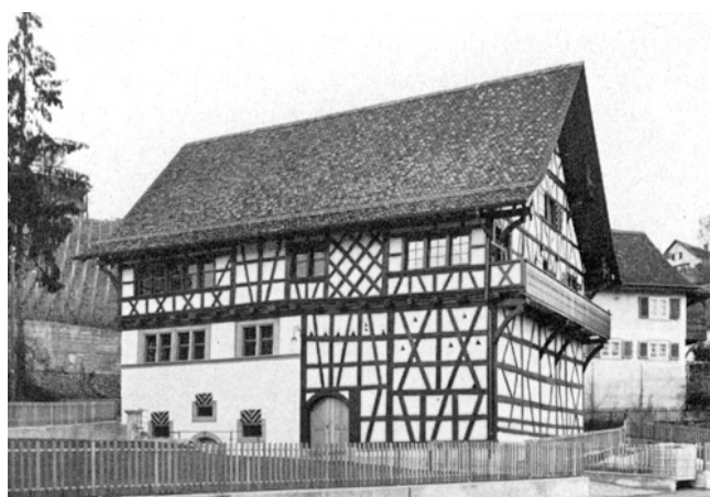
Eglisau. Weiherbach. Weierbachhaus. Ansicht von Südwesten. Nach der Restaurierung von 1976/77.
