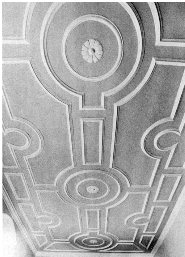
Küsnacht. Hornweg 28. Haus «Seehof». Ostzimmer des 2. Obergeschosses. Stuckdecke. Nach der Restaurierung 1977–1979.
