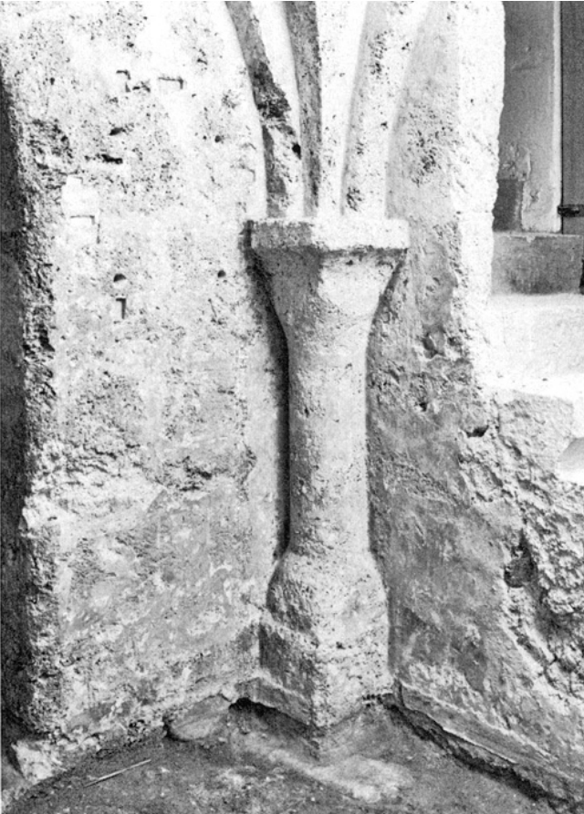
Rüti. Ehemalige Klosterkirche. Archäologische Untersuchung 1980/81. Südliche Seitenkapelle. Nordwestecke mit Tuffsteinsäule.
