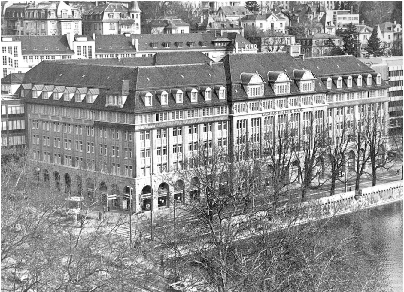
Neumühlequai 10. Kaspar Escherhaus. Nach der Aussenrenovation 1976/77
