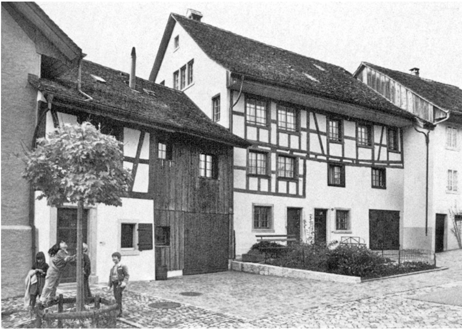
Regensburg. Unterburg. Häuserzeile Vers. Nr. 60/59/58. Nach der Renovation 1978 (zu Seiten 133 f).
