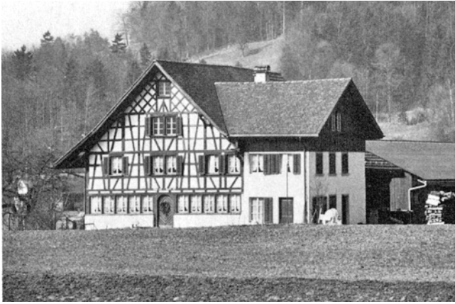
Zell. Untere Rüti. Bauernhaus Vers. Nr. 151. Nach dem Umbau 1977.
