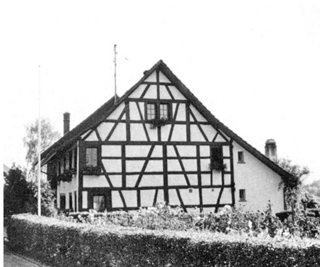
Marthalen. Ellikon am Rhein. Ehemaliges Bauernhaus «Im Lanzig». Nach der Aussenrenovation 1977.
