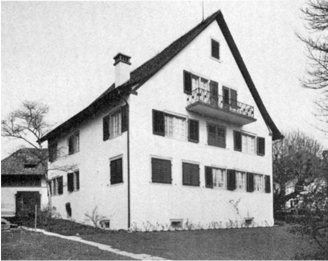
Stäfa. Uerikon. Schorenweg. Ehemaliges Weinbauernhaus «Bim obere Stäg» (Vers. Nr. 75). Nach der Renovation 1978.
