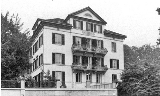
Hottingen. Oben: Rämistrasse 66. Nach der Renovation 1978; Unten: Rämistrasse 62. Nach der Renovation 1978.
