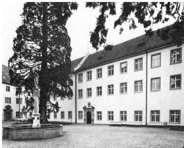
Rheinau. Ehemalige Klosteranlage. Männergasthaus. Nach der Restaurierung 1977/78.
