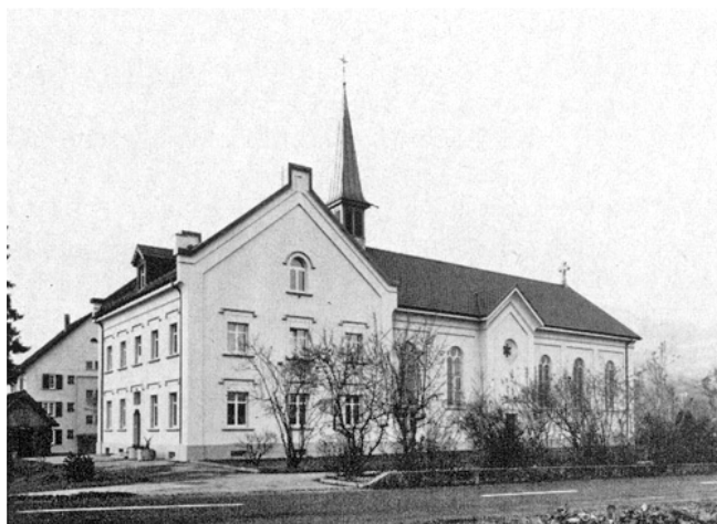
Pfungen. Katholisches Pfarrhaus. Nach der Renovation 1978.
