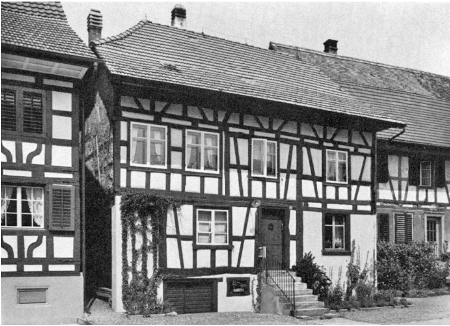
Ossingen. Steinerstrasse. Ehemaliges Bauernhaus Vers. Nr. 72. Nach der Restaurierung 1977.
