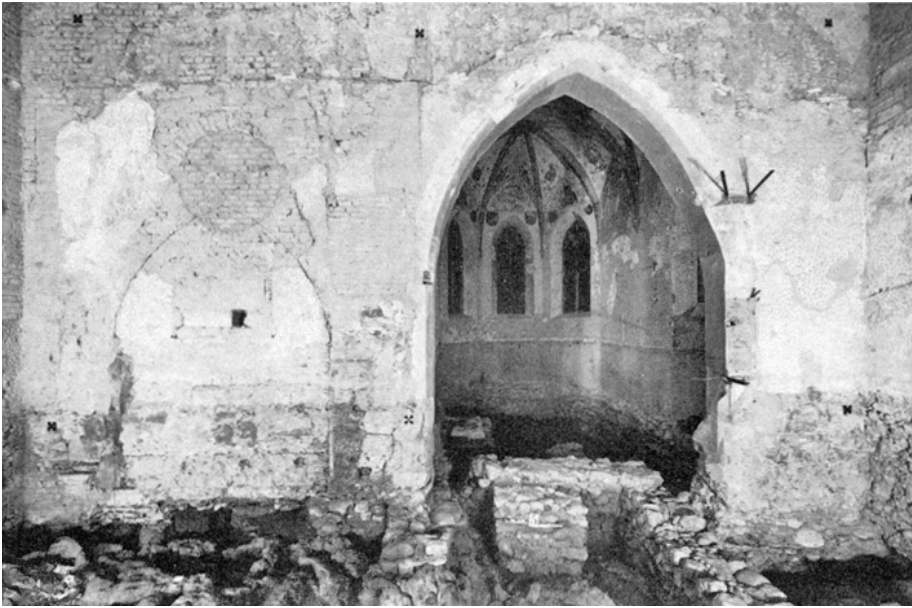
Veltheim. Reformierte Kirche. Archäologische Untersuchung 1977/78. Schiff, Ostwand. Photogrammetrische Aufnahme.
