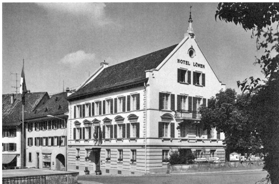
Andelfingen. Hotel Löwen. Nach der Renovation 1970/71.
