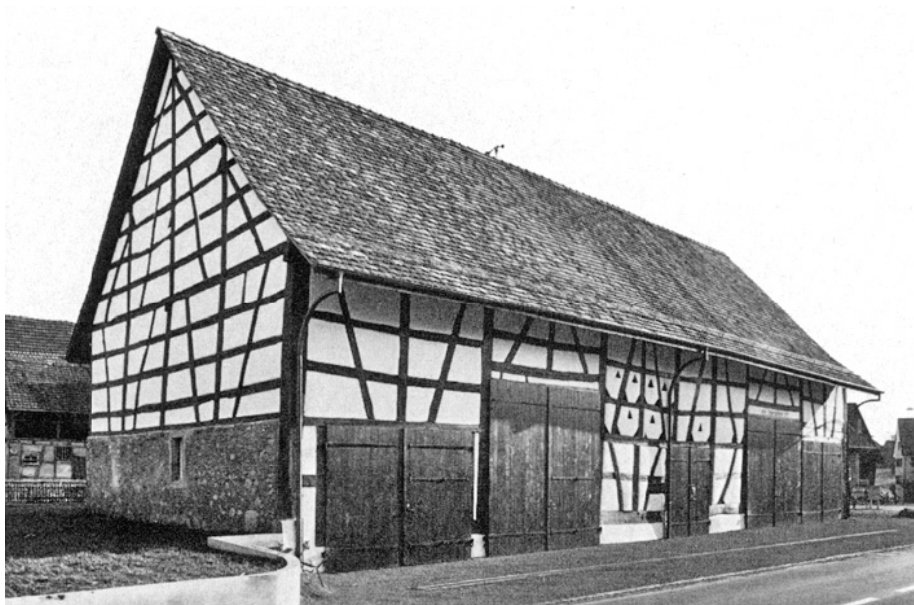
Marthalen. Schaffhauserstrasse. «Rösslicheune». Nach der Renovation 1977.
