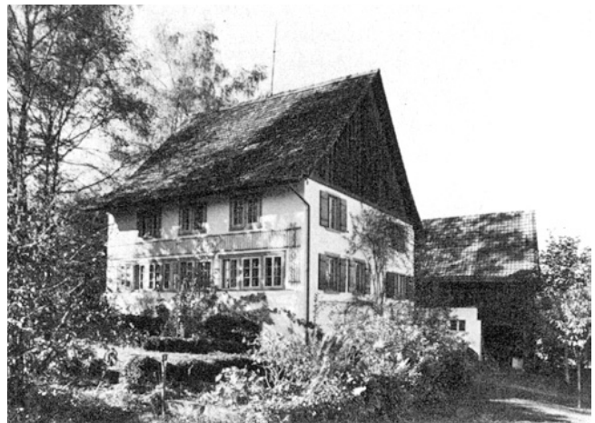
Oetwil a.S. Ehemaliges Schulhaus Vers. Nr. 771. Nach der Renovation 1976/77.
