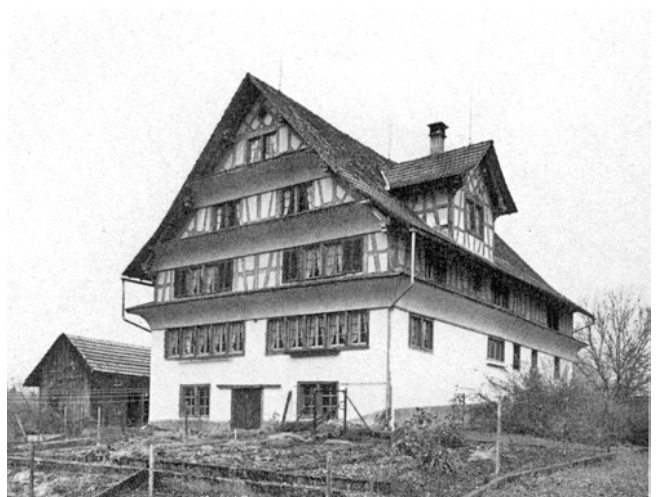
Wald. Tonacher. Bauernwohnhaus Vers. Nr. 1460. Nach der Teilerneuerung von Fenstern 1974–1979.
