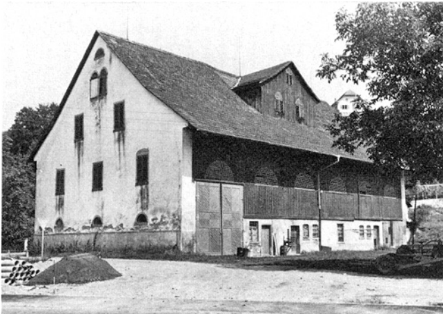
Illnau-Effretikon. Unterillnau. Ökonomiegebäude Vers. Nr. 709, abgebrochen 1977.
