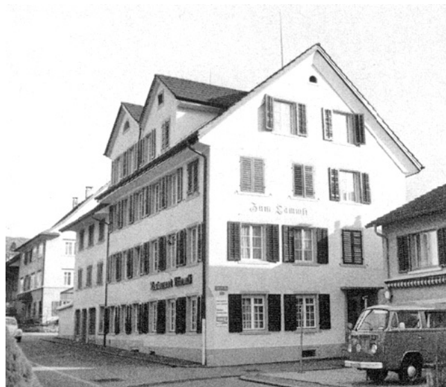
Meilen. Lämmliweg 12, 14/Kirchgasse. Restaurant und Wohnhaus «Zum Lämmli». Nach der Aussenrenovation 1976/77.
