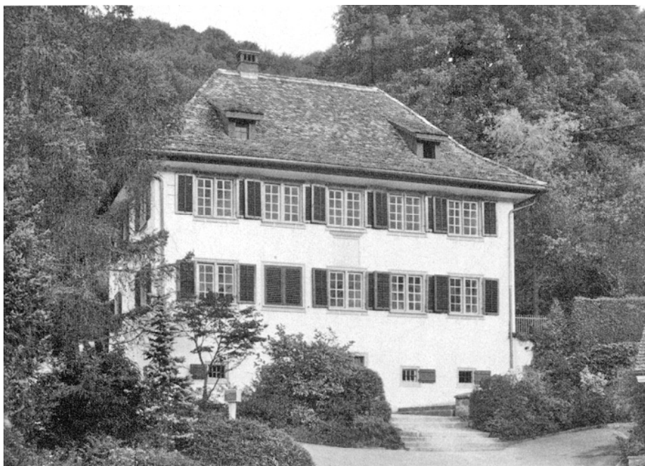
Stallikon. Reformiertes Pfarrhaus. Nach der Renovation 1974 und 1977.
