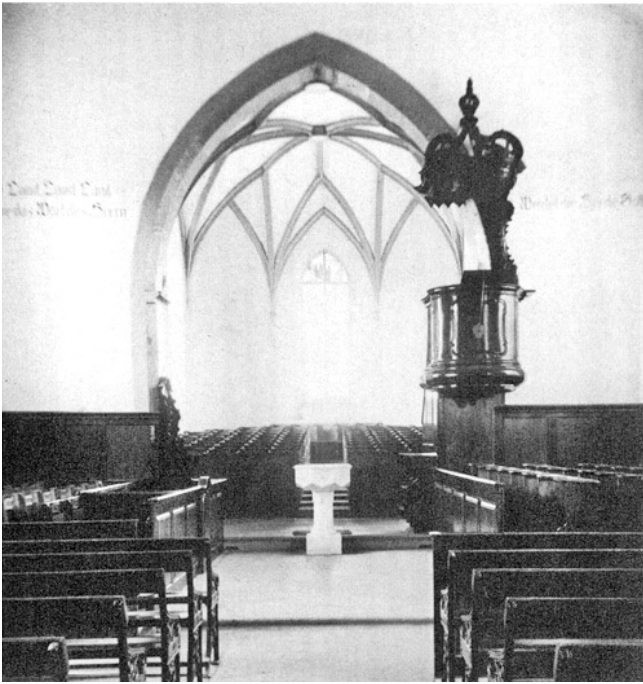
Russikon. Reformierte Kirche. Blick gegen den Chor. Vor der Innenrenovation 1921.
