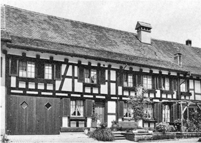
Rafz. Christengasse. Reihenhaus Vers. Nr. 547. Strassenseite. Nach der Aussenrenovation 1977/78.
