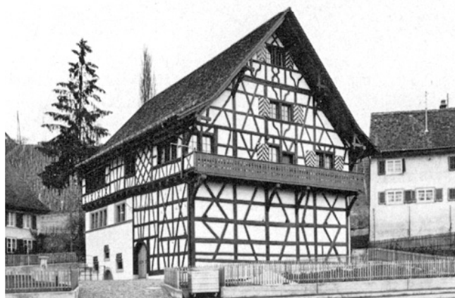
Eglisau. Weiherbach. Weierbachhaus. Ansicht von Süden. Nach der Restaurierung von 1976/77.
