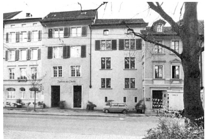
Altstadt. Obertor 6–14/Stadthausstrasse 5–13. Altstadthausensemble. Nach der Sanierung 1975–1977.
