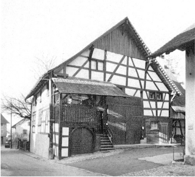
Andelfingen. Schlossegasse. Bauernhaus Vers. Nr. 156. Nach der Renovation 1977.
