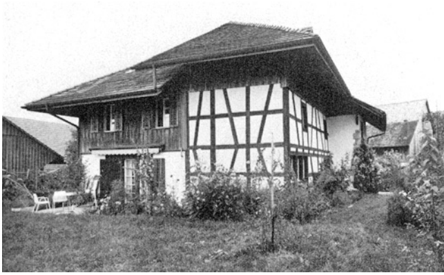
Dorf, Dorfplatz. Ehemaliges Armenhaus. Nach der Restaurierung 1977 (zu Seite 35).
