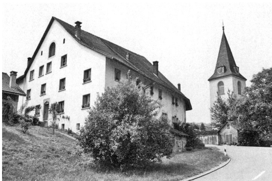
Berg a. I. Haus «Kloster». Nach der Renovation des Hausteils Vers. Nr. 63 a von 1978/79.
