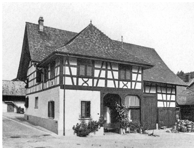
Trüllikon. Wildensbuch. Bauernhaus Vers. Nr. 433. Nach der Aussenrenovation 1978.
