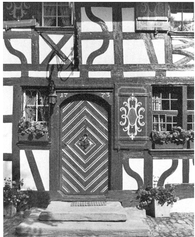
Hettlingen. Eichmühle. Restaurant «Zur Eichmühle». Eingangspartie. Nach der Restaurierung 1977/78.
