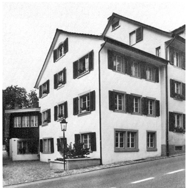
Grüningen. Städtli. Wohnhaus Vers. Nr. 880. Nach der Aussenrenovation 1978.
