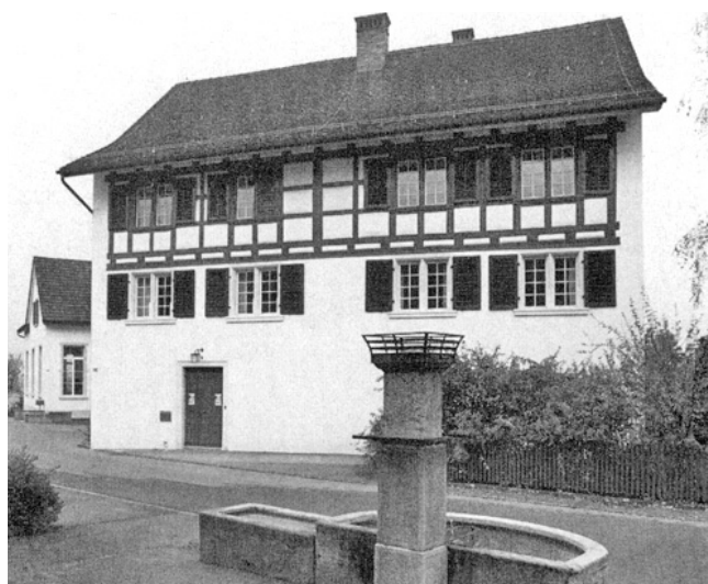
Pfungen. Reformiertes Pfarrhaus. Nach der Renovation 1977/78.
