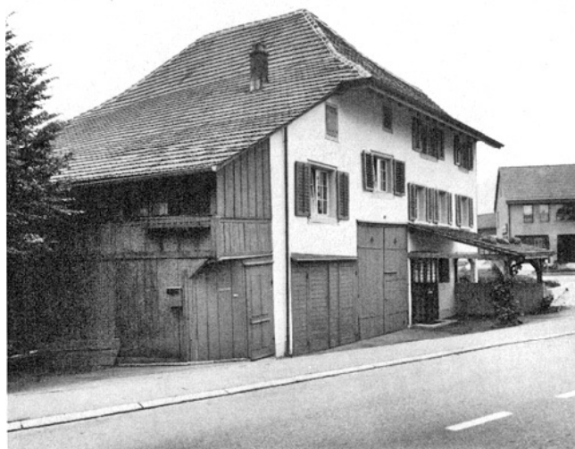
Bülach. Marktgasse 43. Ehemalige Schmiede Vers. Nr. 60. Nach der Restaurierung 1977.
