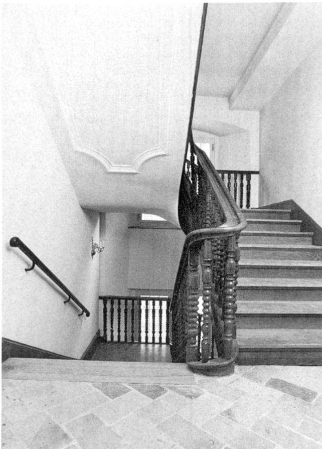
Künstlergasse 15/Sempersteig 3. Stockargut. Herrschaftshaus. Treppenhaus. Nach der Restaurierung 1977/79.
