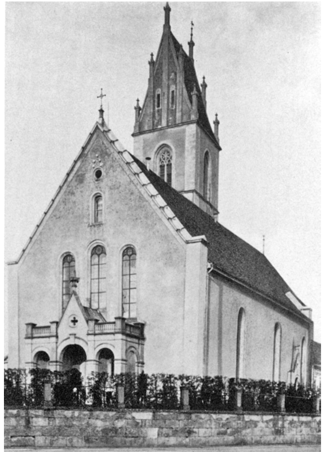
Meilen. Reformierte Kirche. Vor der Renovation von 1926/1927.
