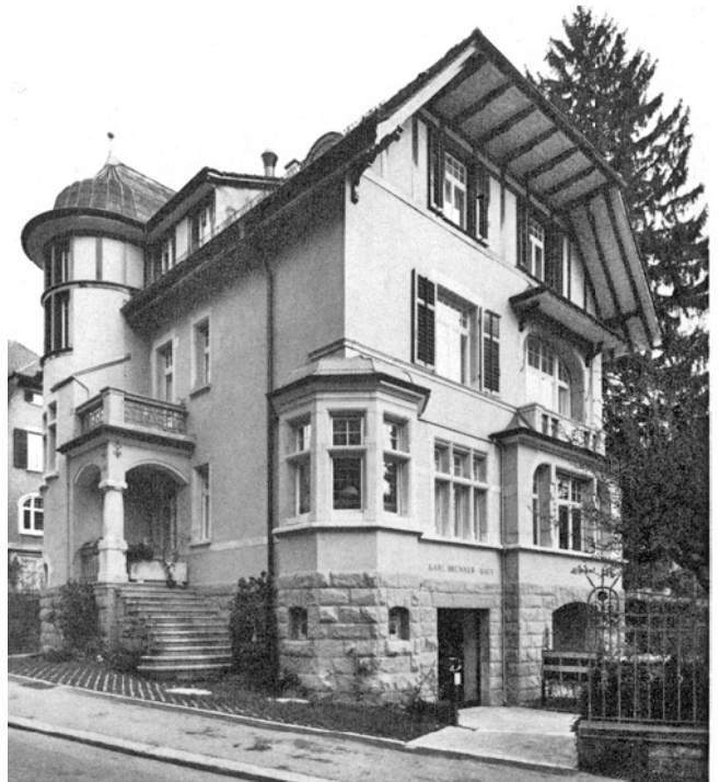
Hottingen. Hauserstrasse 4. «Karl Brunner-Haus». Nach der Restaurierung 1977.
