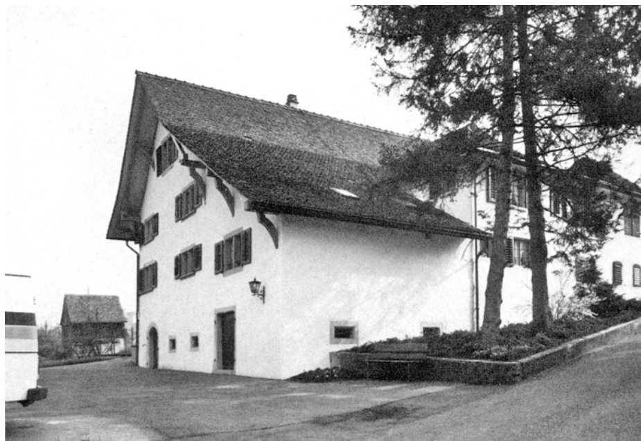
Wädenswil. Au. Schellerstrasse 5. Altersheim «Au» (Vers. Nr. 1645). Nach der Aussenrenovation 1977.
