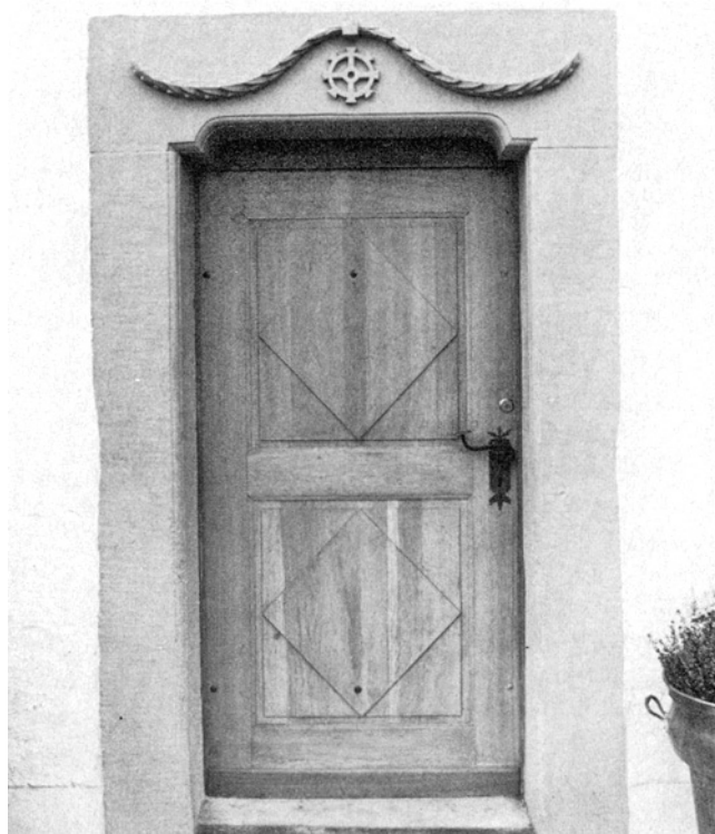
Bäretswil. Kemptertobel. Ehemalige Mühle (Hanfreibe). Haustüre. Nach der Renovation 1977/78.
