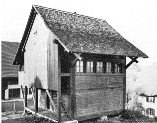
Kappel a. A. Uerzlikon. Ehemaliger Speicher Vers. Nr. 177. Nach der Restaurierung 1977/78.
