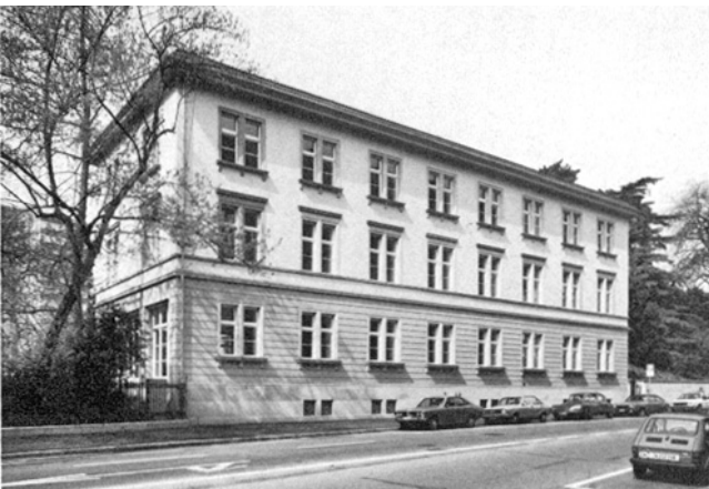
Pelikanstrasse 40/Talstrasse 71. Alter Botanischer Garten. Ehemaliges Sammlungsgebäude, heute Völkerkundemuseum. Nach der Restaurierung 1977/79.
