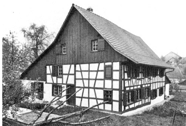
Marthalen. Niederhof. Ehemaliges Bauernwohnhaus. Nach der Restaurierung 1978.
