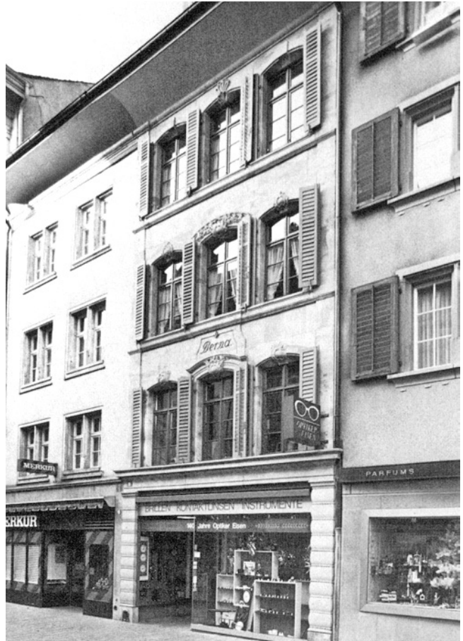
Altstadt. Markt-gasse 16. Haus «Zur Berna». Nach der Restaurierung 1978.
