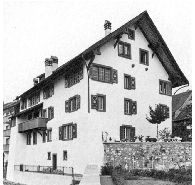
Regensberg. Oberburg. Amtshaus. Nach der Restaurierung 1977/78.
