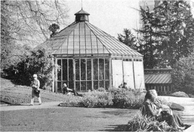
Pelikanstrasse 40/Talstrasse 71. Alter Botanischer Garten. Sog. Palmenhaus von 1851. Vor der Restaurierung 1977/79.
