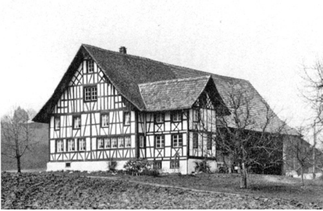
Horgen. Kräh. Bauernhaus Vers. Nr. 1391. Nach der Aussenrenovation 1977.
