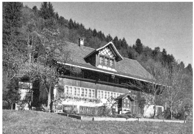
Bauma. Tiefenbach. Ehemaliges Bauernhaus Vers. Nr. 180. Nach der Teilrenovation von 1977.
