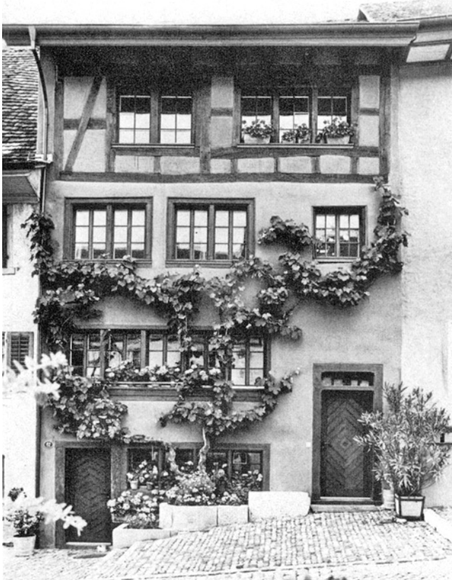
Regensburg. Unterburg. Ehemaliges Kleinbauernhaus «Zum eiser- nen Zeit» (Vers. Nr. 62). Nach der Renovation 1978 (zu Seite 135).
