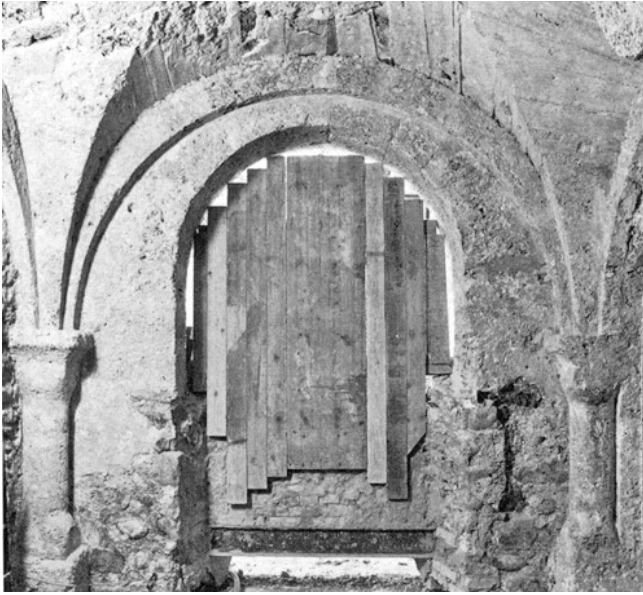
Rüti. Ehemalige Klosterkirche. Archäologische Untersuchung 1980/81. Nördliche Seitenkapelle. Ostwand mit ursprünglicher Fensteröffnung.
