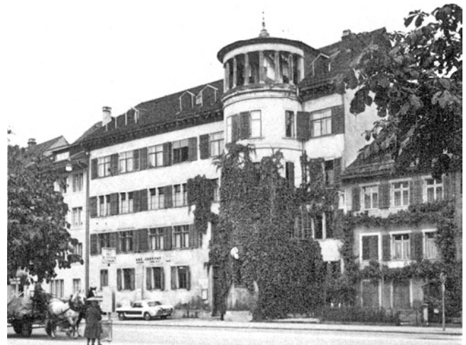
Altstadt. Technikumstrasse 36. Haus «Zum oberen Steinberg». Vor Umbau und Renovation 1976/77.
