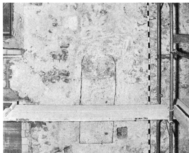
Rütli. Ehemalige Klosterkirche. Archäologische Untersuchung 1980/81. Schiff. Nordwand. Ehemalige Türe zum Dormitorium.
