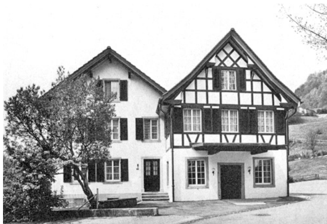
Zell, Hinterdorf. Gebäudegruppe «Zur Schmitte» (Vers. Nr. 99/100). Nach der Renovation 1977/78.
