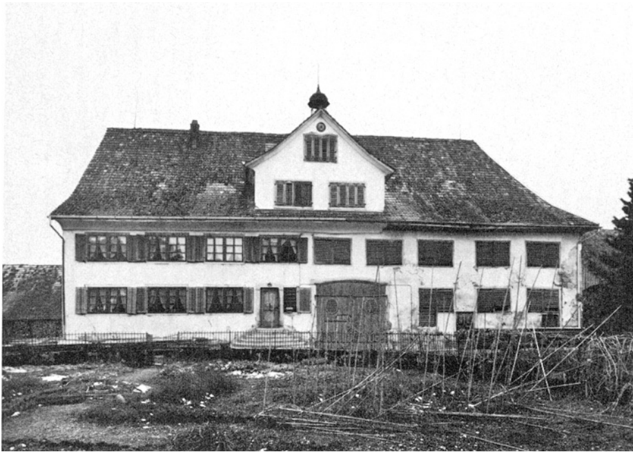
Uster. Winikon. Gschwaderstrasse 84. Ehemalige Statthalterei. Vor der Renovation 1977.
