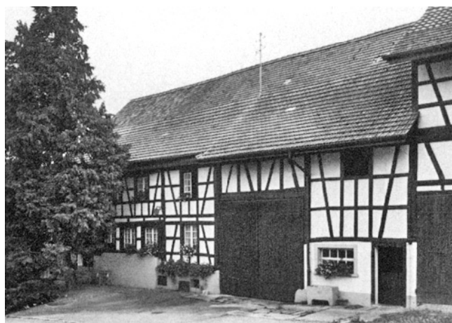
Kleinandelfingen. Alten. Ehemaliges Bauernhaus Vers. Nr. 953. Nach der Renovation 1978.
