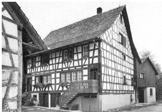
Adlikon. Niederwil. Ehem. Bauernhaus Vers. Nr. 92. Nach der Aussenrenovation 1976/77.
