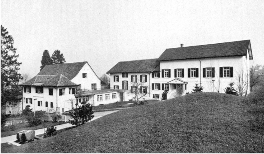
Wädenswil. Au. Schellerstrasse 5. Altersheim «Au» (Vers. Nr. 1645). Gesamtansicht. Nach der Aussenrenovation 1977 (zu S. 213).
