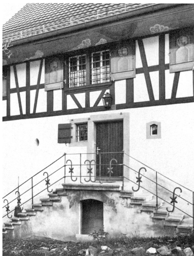
Richterswil. Chrumbächliweg 5. Ehemaliges Weinbauernhaus «Chrumbächli» (Vers. Nr. 608). Nach der Aussenrenovation 1977/78.
