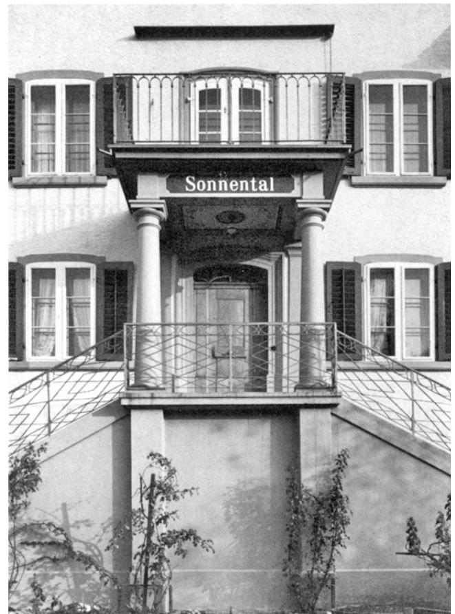
Stäfa. Sonnenthal. Weinbauernhaus «Sonnental» (Vers. Nr. 1478). Nach der Aussenrenovation 1977.
