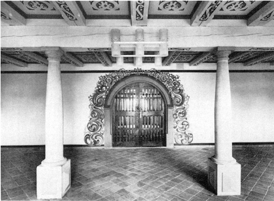
Küsnacht. Hornweg 28. Haus «Seehof». Sala terrena. Nach der Restaurierung 1977–1979.
