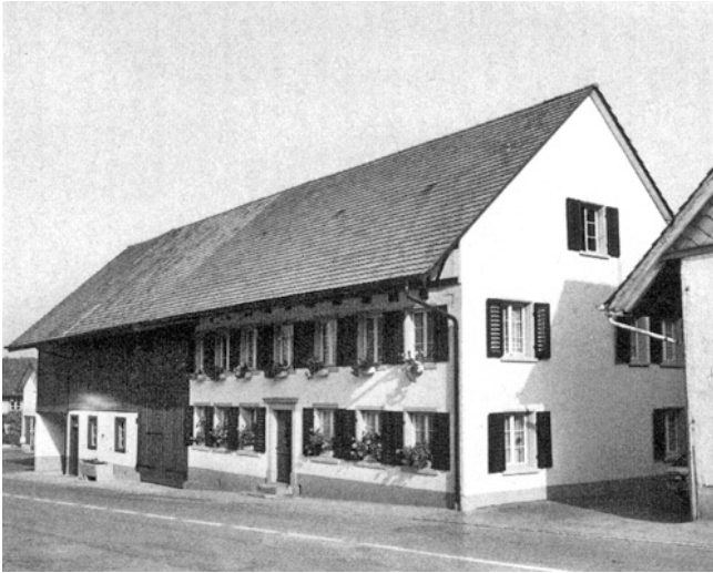
Altikon. Thurstrasse 105. Bauernhaus Vers. 105. Nach der Restaurierung 1977.
