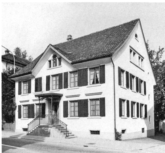
Uster. Kirchuster. Zentralstrasse 34. Wohnhaus Vers. Nr. 2435. Nach der Aussenrenovation 1977.
