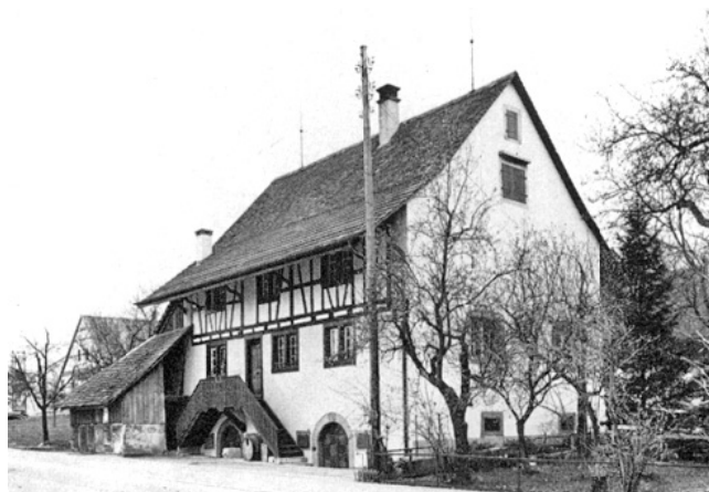
Hüttikon. Zürcherstrasse. Ehemaliges Bauernhaus Vers. Nr. 31 a. Nach der Aussenrenovation 1977/78.
