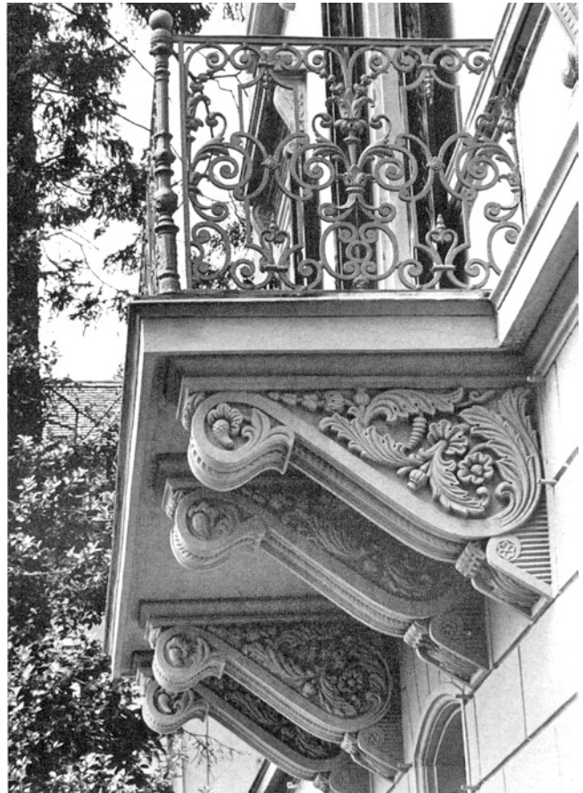
Hottingen. Rämistrasse 66. Balkondetail. Nach der Restaurierung 1978.
