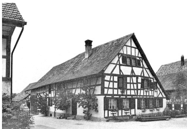
Unterstammheim. Unterdorf. Ehemaliges Bauernhaus Vers. Nr. 135. Nach der Renovation 1976/77.
