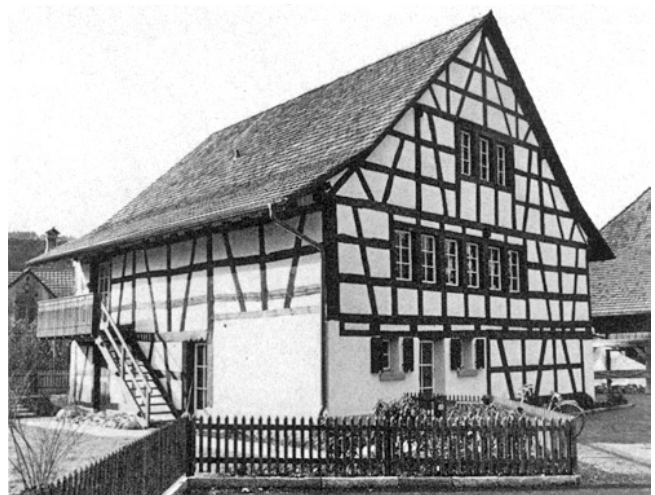
Berg a. I. Ehemalige Scheune beim Haus «Kloster», heute Kirchgemeindehaus Vers. Nr. 60. Nach dem Umbau von 1978.
