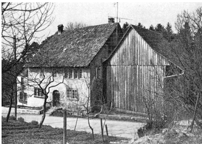
Regensdorf. Altburg. Ehemaliges Vogthaus (Vers. Nr. 9). Vor der Restaurierung 1976/77.
