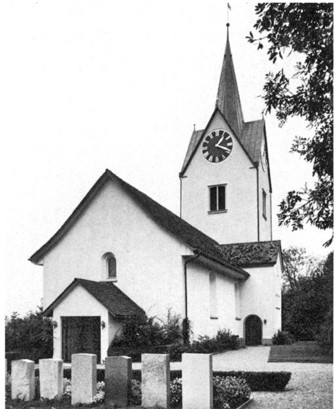
Buch a. I. Reformierte Kirche. Nach der Aussenrenovation von 1977.
