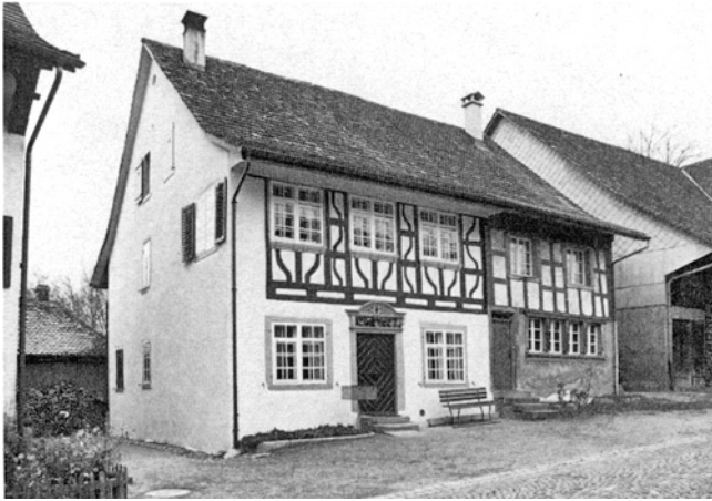
Kyburg, Vorburg ehemaliges Städtchen). Doppelwohnhaus Vers. Nr. 297/99. Nach der Aussenrenovation 1978/80.
