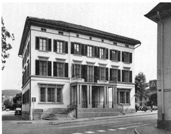
Pfäffikon. Hochstrasser. Gemeindehaus. Nach der Renovation 1977/78.
