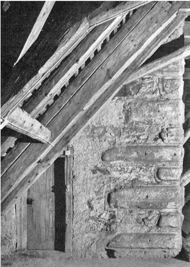
Egg. Reformierte Kirche. Turmteil im Dachgeschoss des Schiffes mit originalen Eckbossen.
