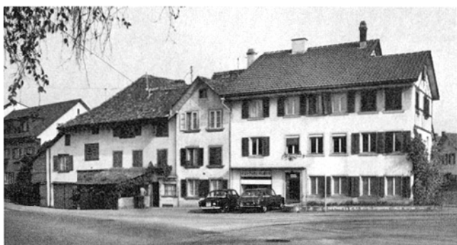
Bülach. Marktgasse 43. Ehemalige Schmiede, Vers. Nr. 60. Vor dem Abbruch der angebauten Häuser ehemals Zürichstrasse 45 und 47 von 1973.
