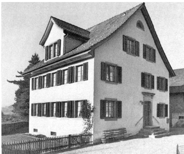
Hittnau. Luppmen. Wohnhaus Vers. Nr. 685. Nach dem Umbau zum Altersheim 1977.
