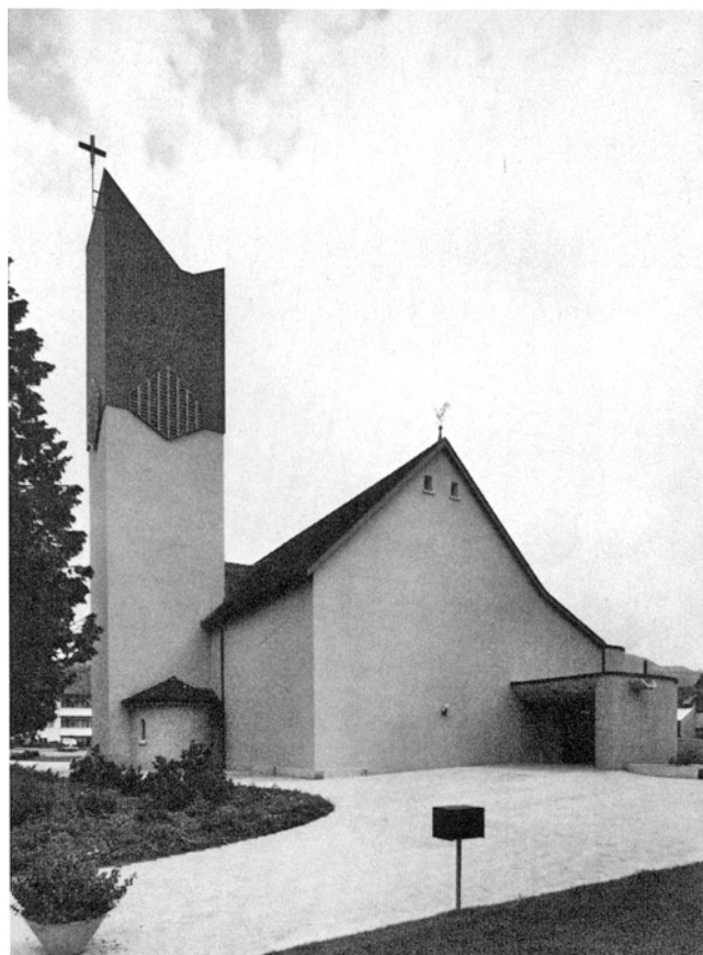
Hinwil. Katholische Kirche Liebfrauen. Von Westen. Oben: vor dem Umbau; unten: nach dem Umbau 1977/78.
