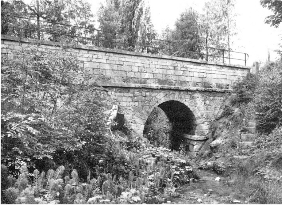
Flaach. Schollenberg. Alte Tuffsteinbrücke. Nordseite. Nach der Restaurierung 1977/78.
