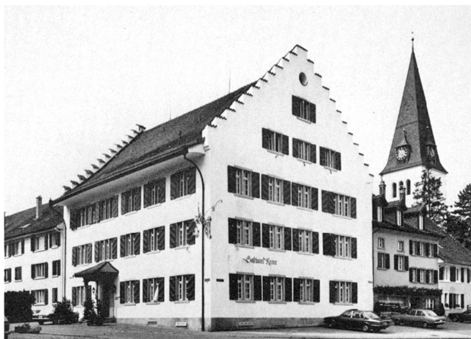
Elgg, Obergasse. Gemeindehaus (ehemals Gasthaus «Zur Krone»). Nach der Renovation 1977/78.
