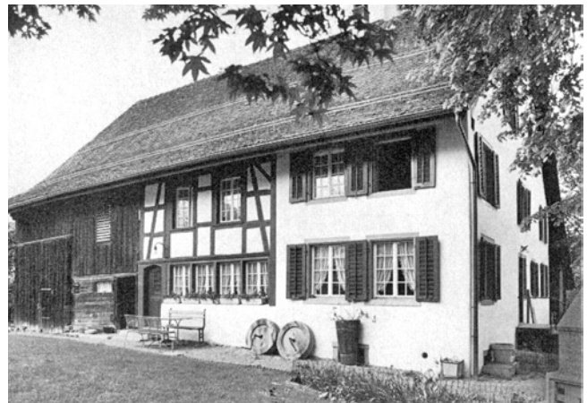
Wetzikon. Unterwetzikon. Bühlstrasse 29, 31. Ehemaliges Doppelbauernhaus Vers. Nr. 1485. Nach der Renovation 1976/77.
