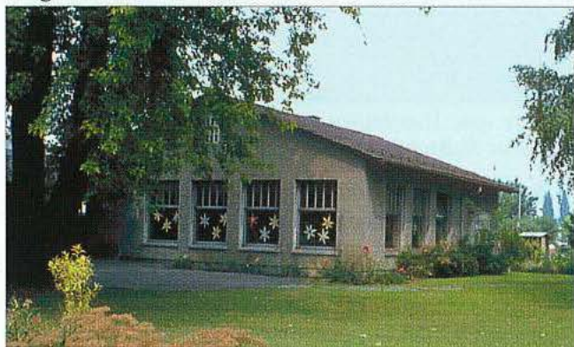
Der einstige zweite Kindergarten Feldstrasse ist heute ...
