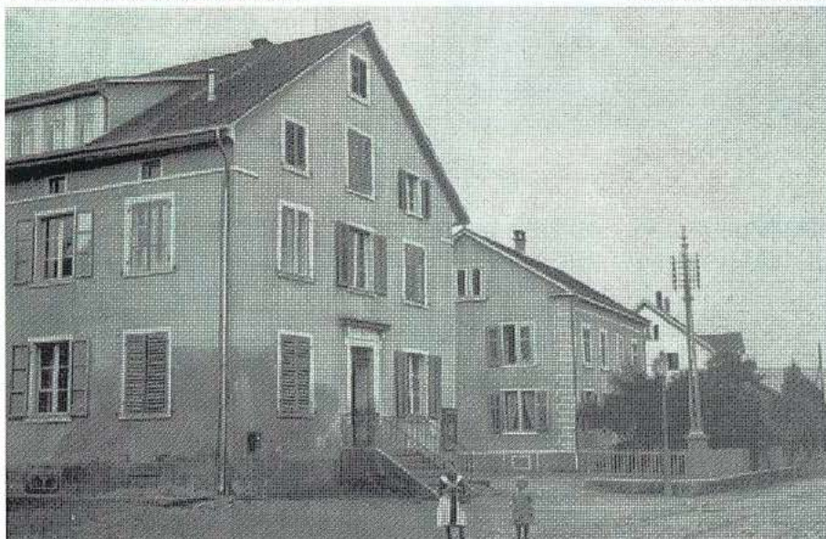
Das Schulhaus Badenerstrasse 9. (Aufnahme um 1910)
