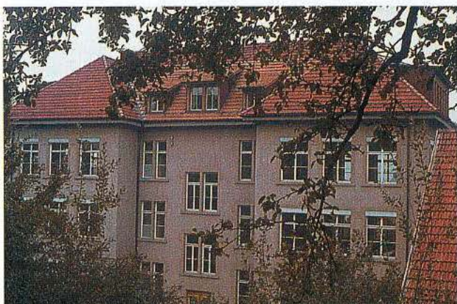
Hier hinter dem Schulhaus Grabenstrasse unten auf dem Areal des einstigen «Tobelhofs» hätte Schlierens erstes Schul-Hallenbad entstehen sollen.
