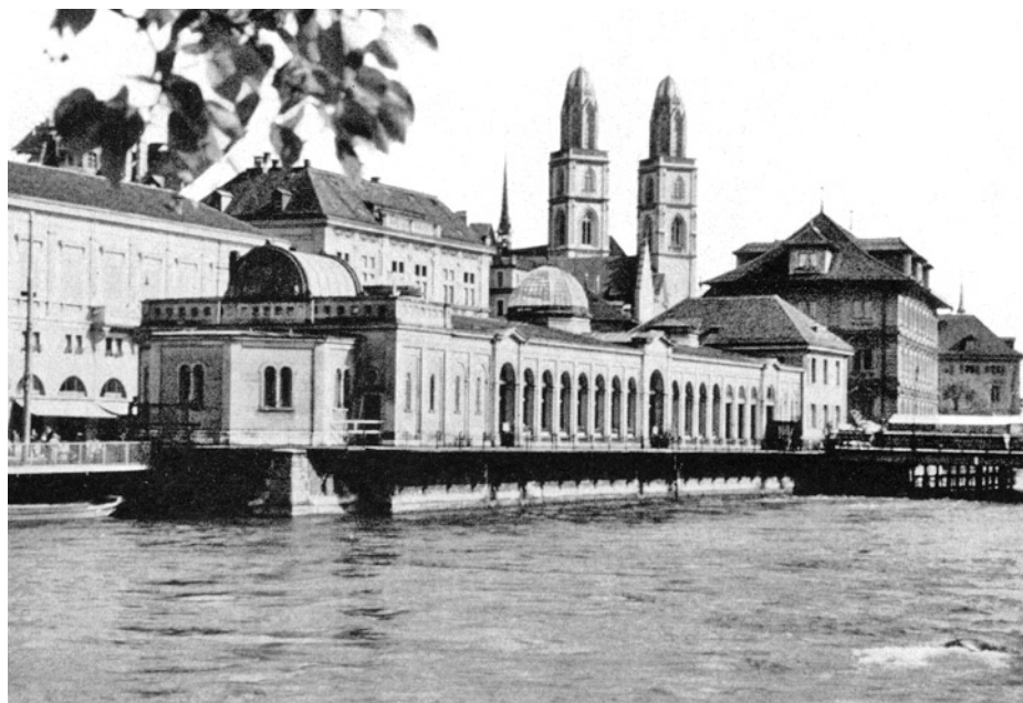
Limmatquai 63. Ansicht der Fleischhalle von der Schipfe aus.
