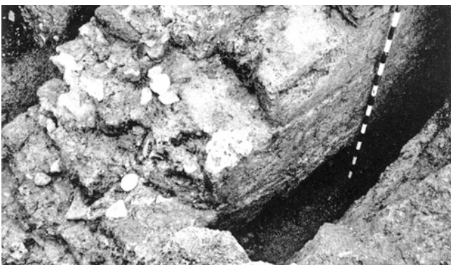
Bauma – Alt-Landenberg. Nordende der Tuffsteinmauer der dritten Bauetappe zwischen Westhalle und Vorhof des Teiles A, von Nordwesten gesehen.
