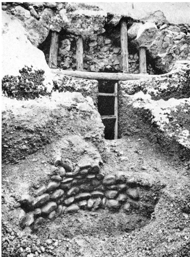
Winterthur – Altstadt. Marktgasse 4. Sickergrube 1, dahinter alter Bogen für den ehemaligen Ehgraben. Aus Westen gesehen.
