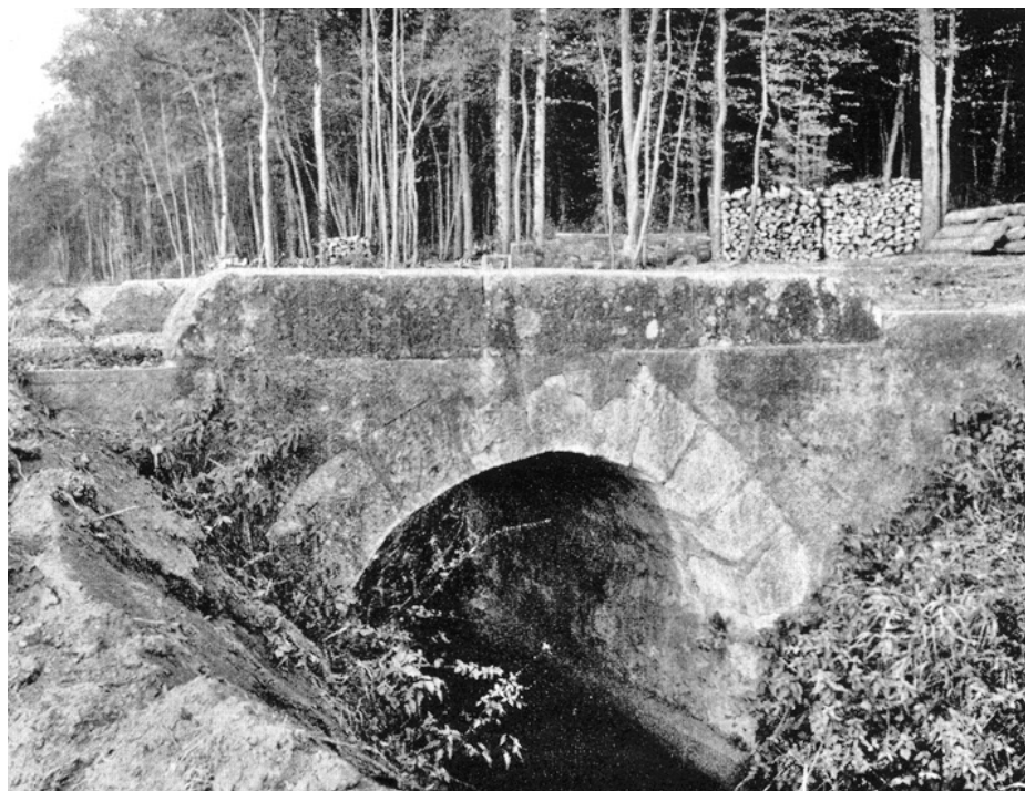
Marthalen – Abistbach. Das sogenannte «Römerbrüggli», welches 1962 dem Strassenbau weichen musste.
