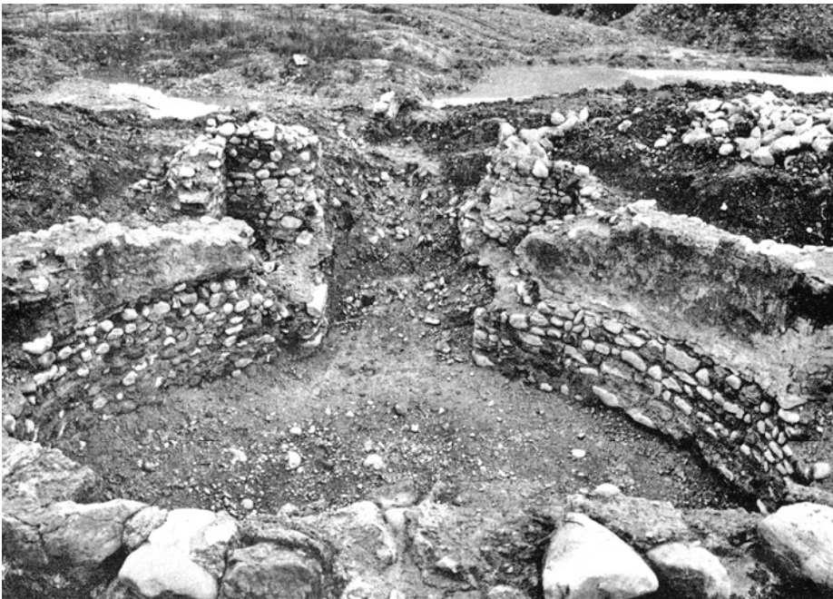
Winkel – Römischer Gutshof bei Seeb. Das Brunnenhaus im Zustand bei Beginn der Konservierungsarbeiten im November 1963. Aus Süden gesehen. Im Hintergrund die Kiesgrube, in welche grosse Teile der Fundamentmauern für die Zugangsrampe gestürzt sind.
