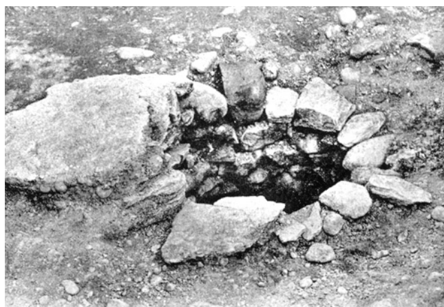
Winkel – Römischer Gutshof bei Seeb. Brunnenhaus. Der Sodbrunnen mit dem letzten Fragment des alten Mörtelbodens (links vom Steinkranz). Aus Nordwesten. Zustand im Herbst 1961.
