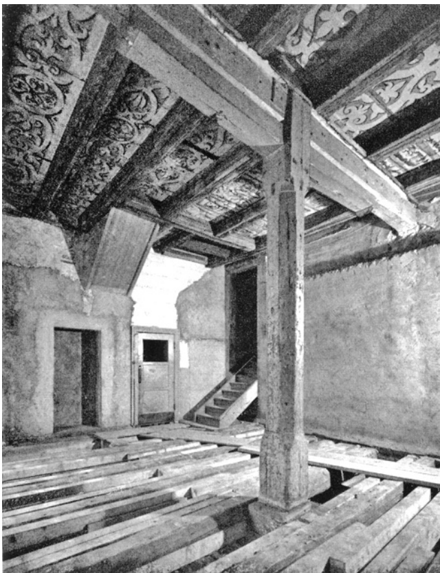
Ingassen 3. Ehemaliger Prunksaal im ersten Stock.
