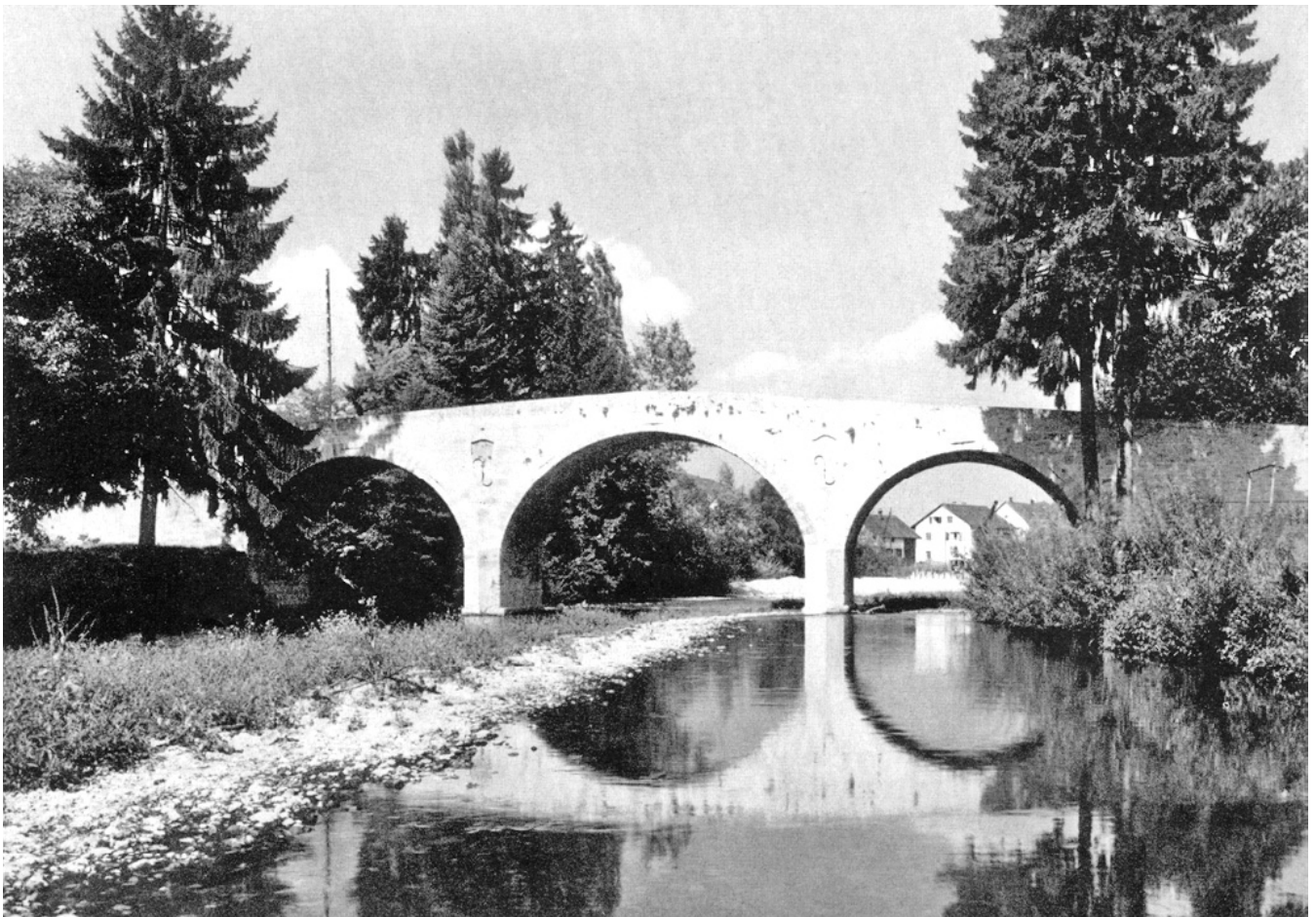
Freienstein/Rorbas – Die sogenannte «Römerbrücke» von 1806, nach der Verstärkung und Restaurierung von 1961. Blick flussabwärts
