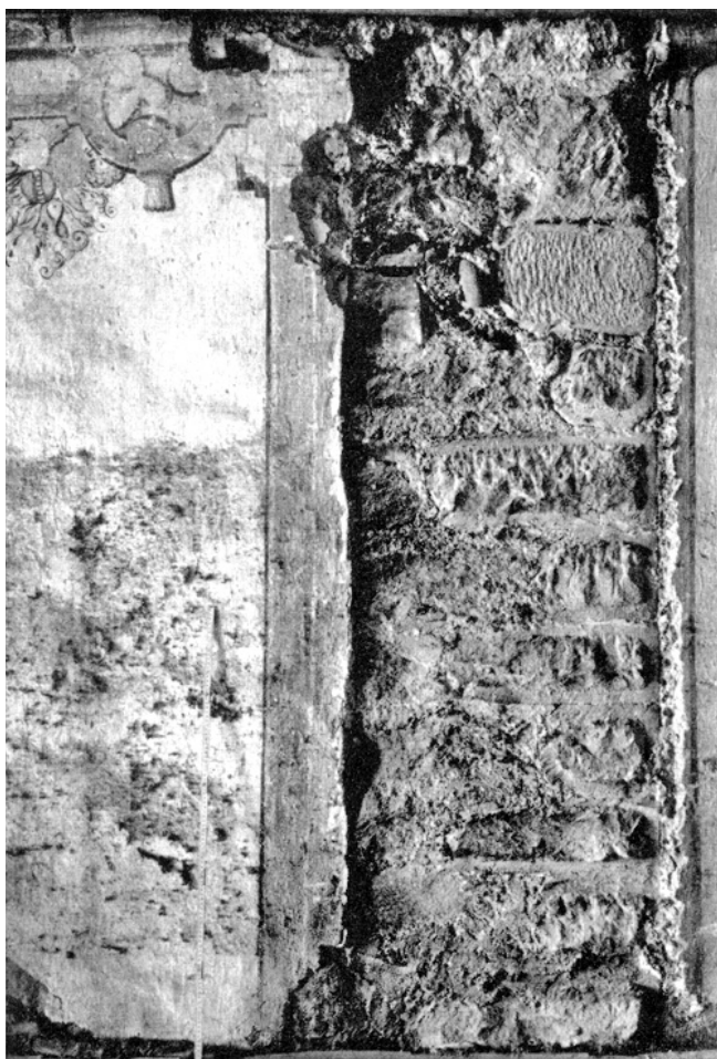
Winterthur – Altstadt. Stadthausstrasse 75. Wandmalereien des frühen 17. Jahrhunderts. Das westliche Ende der Ostwand, rechts davon Tuffsteinecke des östlich anschliessenden Hinterhauses.
