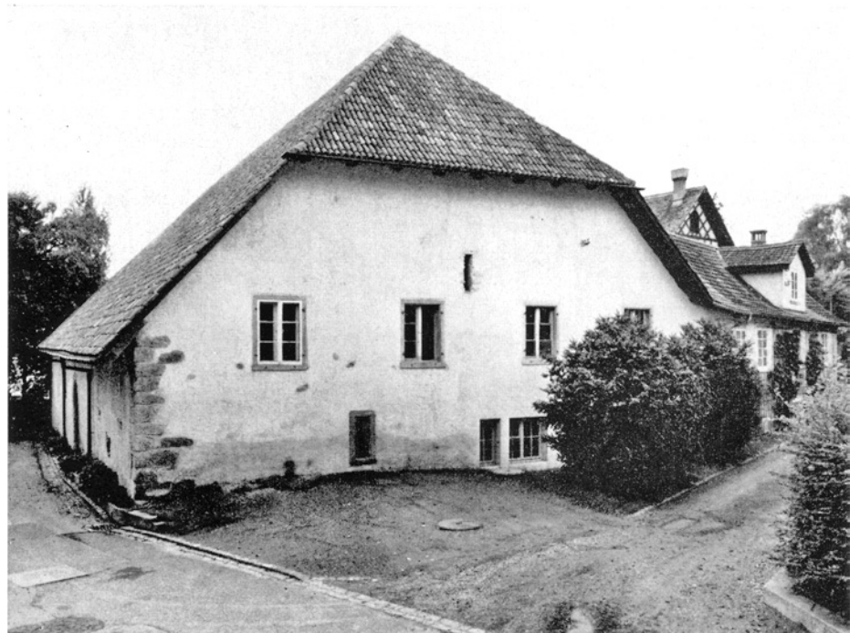
Küsnacht – Zehntentrotte. Die Ostfassade mit späteren Fensterausbrüchen, nach der Renovation von 1961/63.
