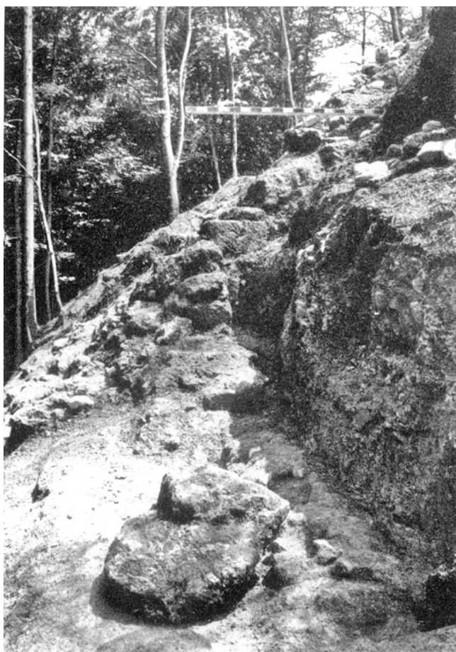
Bauma – Alt-Landenberg. Die Fundamentgrube der nördlichen Tuffsteinmauer der dritten Bauetappe des Teiles A, aus dem Westen gesehen.
