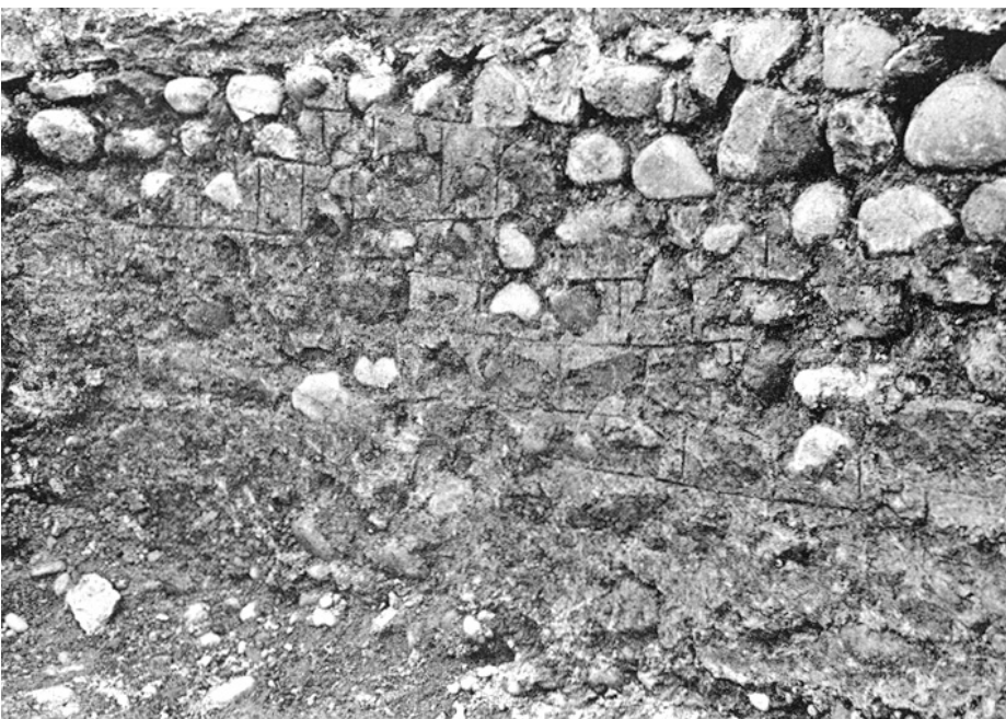
Winkel – Römischer Gutshof bei Seeb. Brunnenhaus. Detail aus dem nordwestlichen Segment der Rundmauer mit deutlich erkennbarem Fugeisenstrich im Mörtel. Zustand im Herbst 1961.
