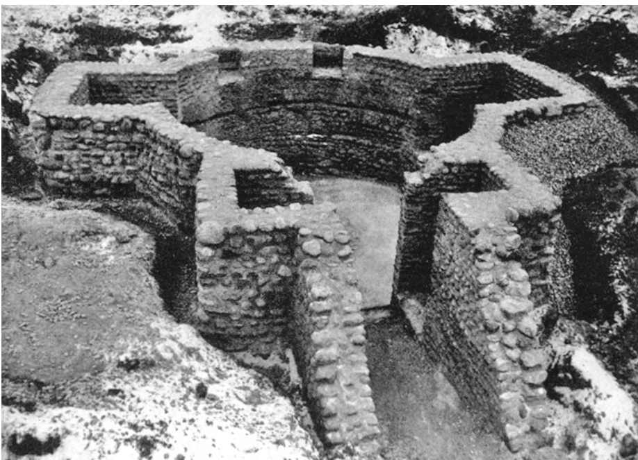
Winkel – Römischer Gutshof bei Seeb. Das Brunnenhaus während der Konservierungsarbeiten im Dezember. 1963: Einschütten des Kieskoffers ausserhalb der Rundmauern. Aus Norden.
