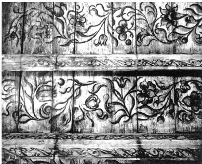
Hottingen – Zeltweg 69. Detail der Sichtbalkendecke im zweiten Stock.
