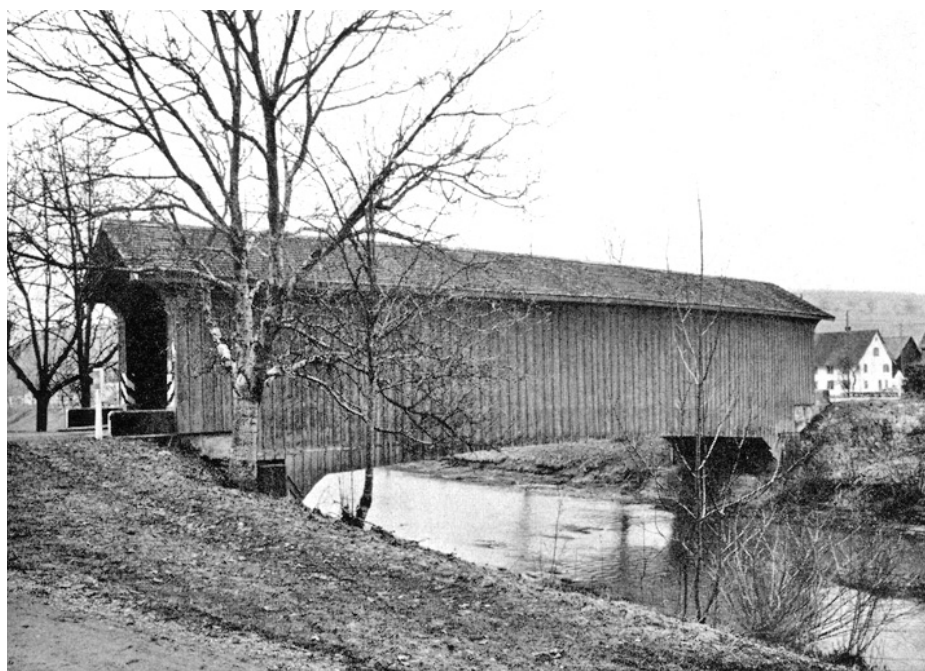
Zell – Kollbrunn. Die hölzerne Tössbrücke von 1838/39, abgebrochen im Winter 1963/64. Blick flussabwärts.
