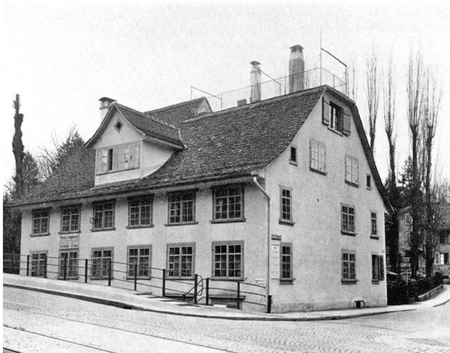
Enge – Gutenbergstrasse 1 und 3. Das durch die Strassenbauten stark beeinträchtigte Haus von Nordosten.
