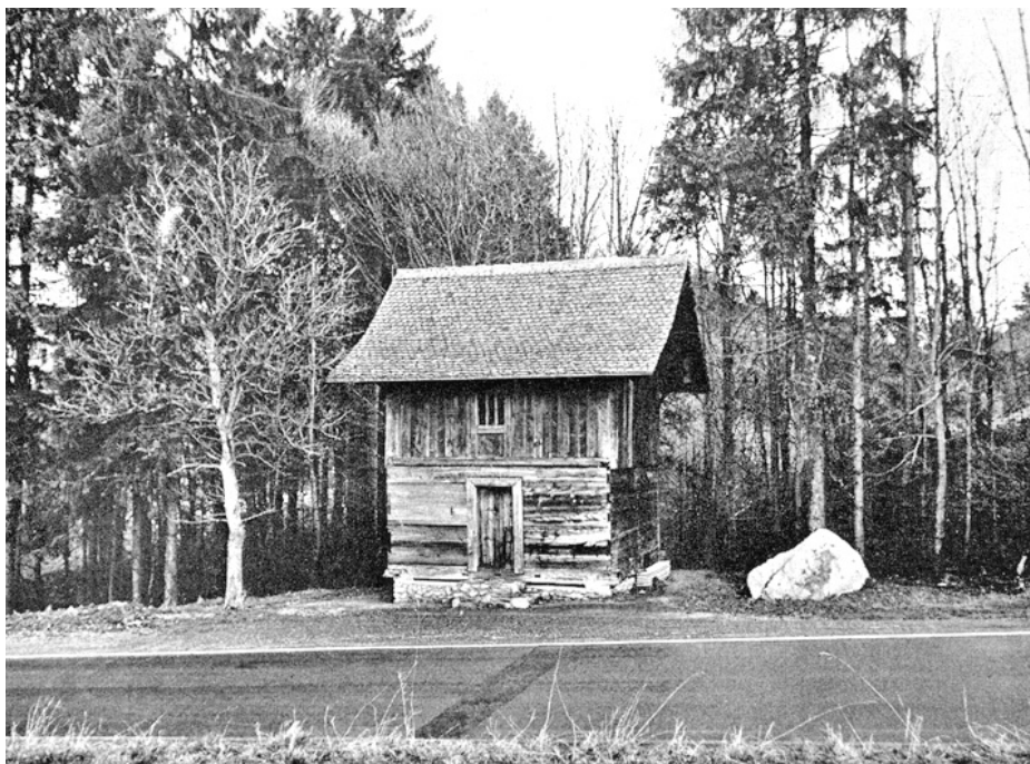
Zollikon – Zollikerberg, Binzstrasse. Alter Speicher aus der Underhueb. Zustand im Dezember 1965. Aus Westen.
