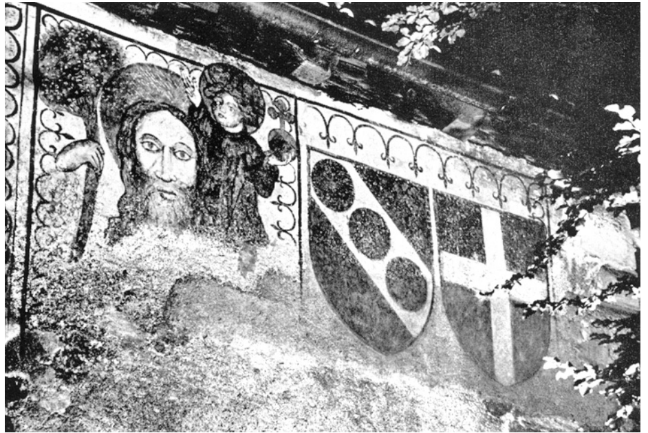
Küsnacht – Zehntentrotte. Detail aus der Fassadenmalerei des frühen 14. Jahrhunderts, nach der Restaurierung von 1961/63.
