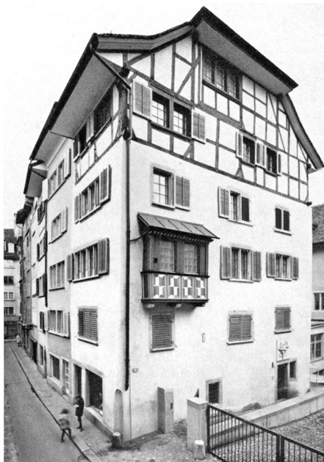
Froschaugasse 20–24 nach dem Umbau.
