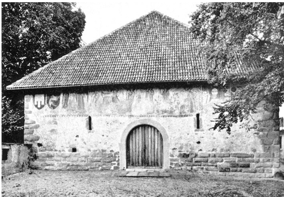
Küsnacht – Zehntentrotte. Die West- oder seeseitige Fassade mit den Male- reien des frühen 14. Jahrhunderts. Nach der Restaurierung von 1961/63.
