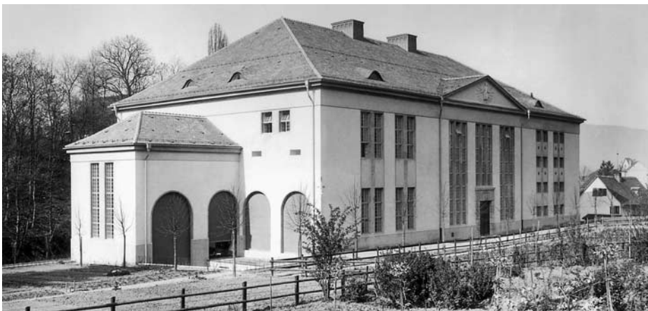
Umformerstation Drahtzug des städtischen Elektrizitätswerks (EWZ) an der Hammerstrasse 62. Projekt und Bauleitung durch das städtische Hochbauamt (Hermann Herter), Fassadenpläne von Architekt Emil Schäfer (1878–1959), abgebrochen 1982. Photo ZDA.
