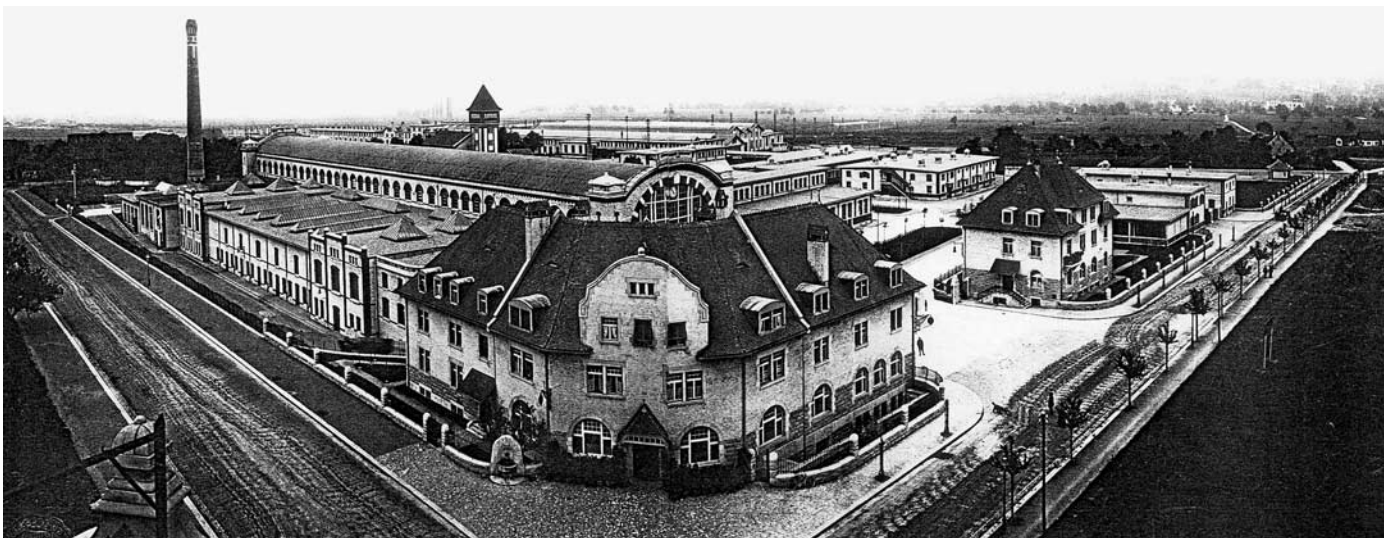
Der Schlachthof gehört zu den grössten städtischen Bauvorhaben des frühen 20. Jahrhunderts. Ein eigenes Baubüro des Hochbauamtes unter Gotthilf Korrodi (1875–1948) betreute den Bau. Gesamtansicht der Anlage von Süd-osten nach der Vollendung 1909. BAZ, Photo Wolf-Bender, um 1910.
