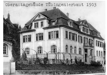
Ein Frühwerk Friedrich Fisslers: das Oberamtsgebäude in Tübingen, das er 1903 als Beamter der königlich-württembergischen Domänenverwaltung erbaute. Postkarte. StadtA: VII.141 (Nachlass Fissler).
