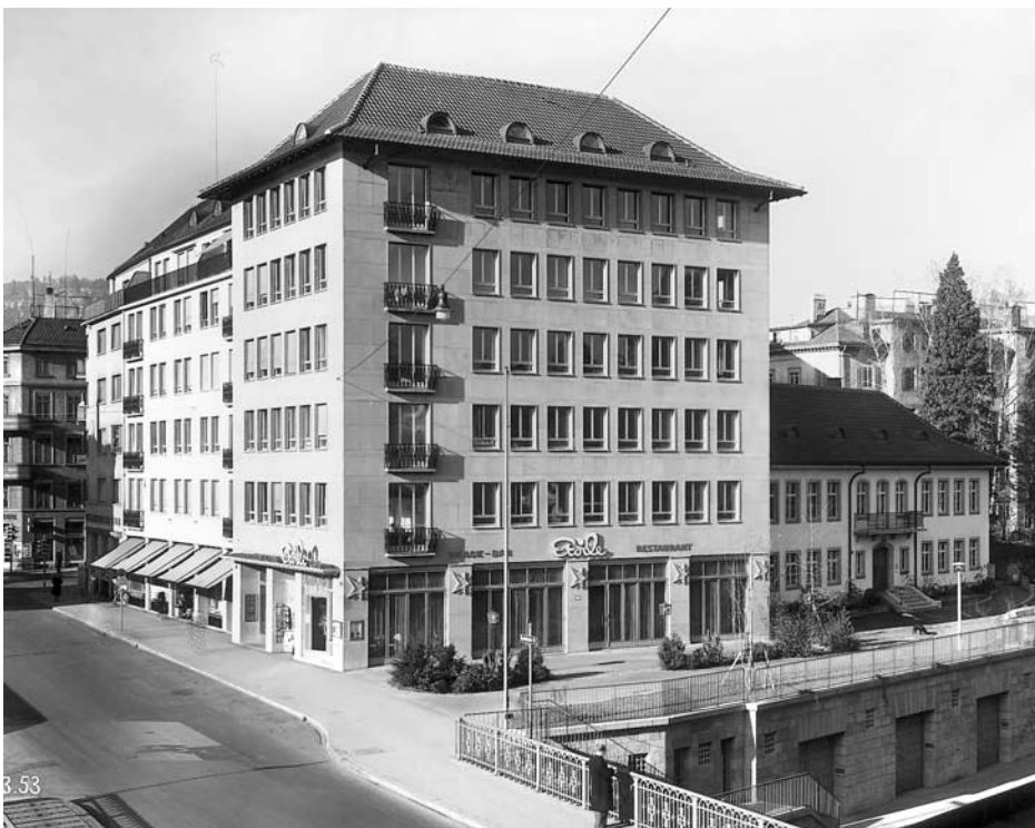
Der Gebäudekomplex zwischen Schanzengraben, Brandschenke- und Selnastrasse entstand 1951 nach intensiver Beratung und mit Hilfe von Überbaustudien des Hochbauamtes. Er hält sich noch an die Baulinien, zeigt aber bereits eine Differenzierung von Bauhöhen und Kubatur. BAZ, Photo Wolf-Bender 1953. – Text S. 97.
