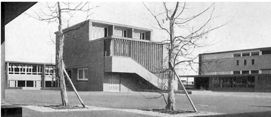
Das Schulhaus Letzi (1956) von Architekt Ernst Gisel (geb. 1922) liegt in einem Grünzug in Albisrieden, die Baumasse ist in nach Funktionen getrennte ein- und zweigeschossige Einzelkörper aufgegliedert, die durch gedeckte Laufgänge miteinander verbunden sind. Der zentrale Singsaalbau dominiert die Anlage. Neu sind die Atriumform, die strenge Geometrie der Baukörper und Sichtbeton sowie Sichtbackstein als vorherrschende Materialien. Wasserfallen 1957.
