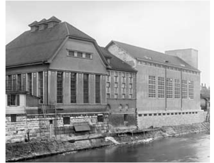
Links: Umformerstation des städtischen Elektrizitätswerks (EVW) an der Selnaustrasse 25, erbaut 1914. Rechts: Unterwerk Selnau im Bau. Zustand vor dem vollständigen Umbau der Umformerstation. Vgl. Abb. unten. BAZ, Photo um 1932.
