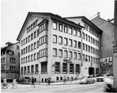
Der Neubau mit Poststelle von 1948 an der Mühlegasse 11 wurde an der Mühlegasse und Niederdorfstrasse von der Baulinie zurückgesetzt, in der Höhe gestaffelt und mit Erker, Fenstersprossen und Torbogen als Reminiszenzen an die umgebende Altstadt versehen. Der rückseitige Hof wurde erweitert. BAZ, Photo 1968.
