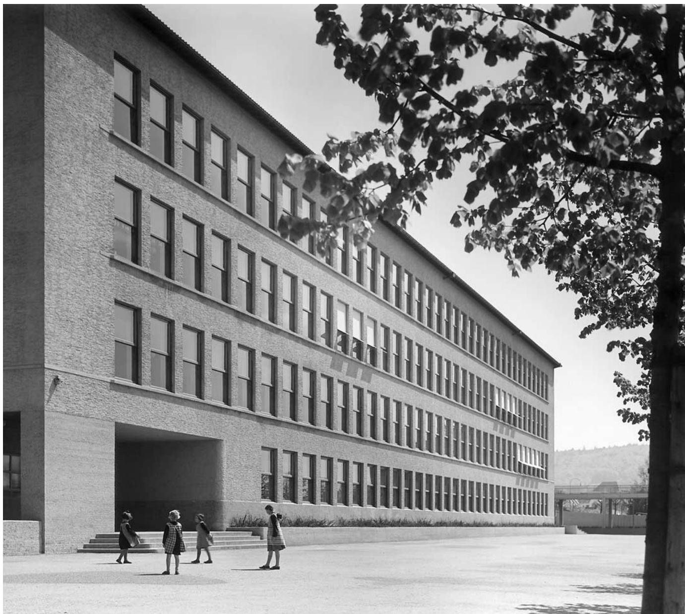
Das Schulhaus Waidhalde am Weihersteig in Wipkingen, erbaut 1932–1933 von Stadtbaumeister Hermann Herter. Vgl. S. 65/66. BAZ, Photo Hans Finsler (1891–1972), Zürich.
