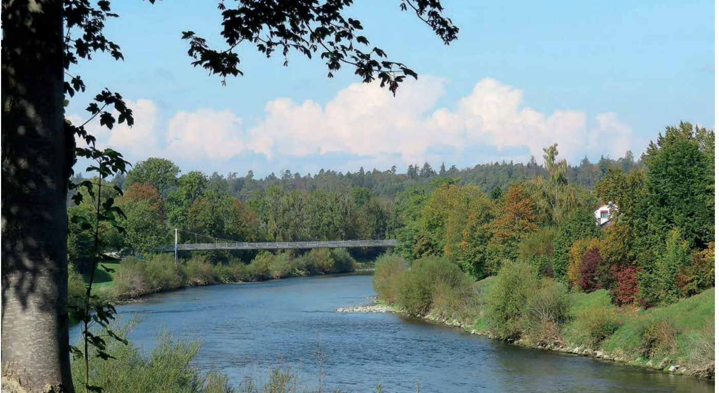
Sicht auf die Hängebrücke bei der ARA
