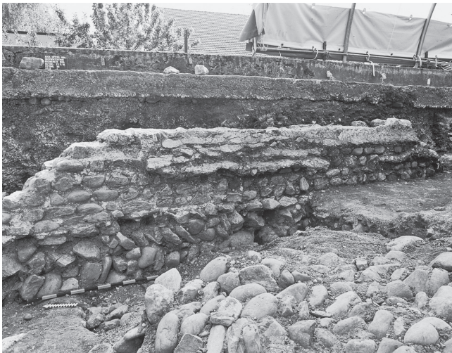
Abb. 49. Römerstrasse 169a. Siedlungshorizont 3. Gebäude A. Ansicht der Westwand Pos. 116 von aussen, mit dickem Terrazzoverputz (Fundament und Aufgehendes).
