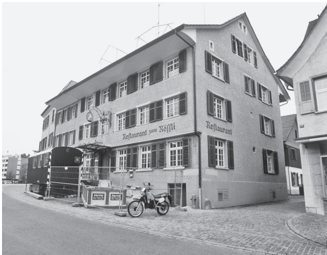
Abb. 5. Römerstrasse 173. Restaurant zum Rössli (Ansicht von Osten).
