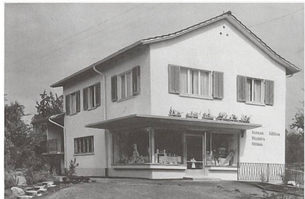
6 Filiale Adlikon mit Milchsammelstelle und Gemeinschaftstiefkühlanlage
