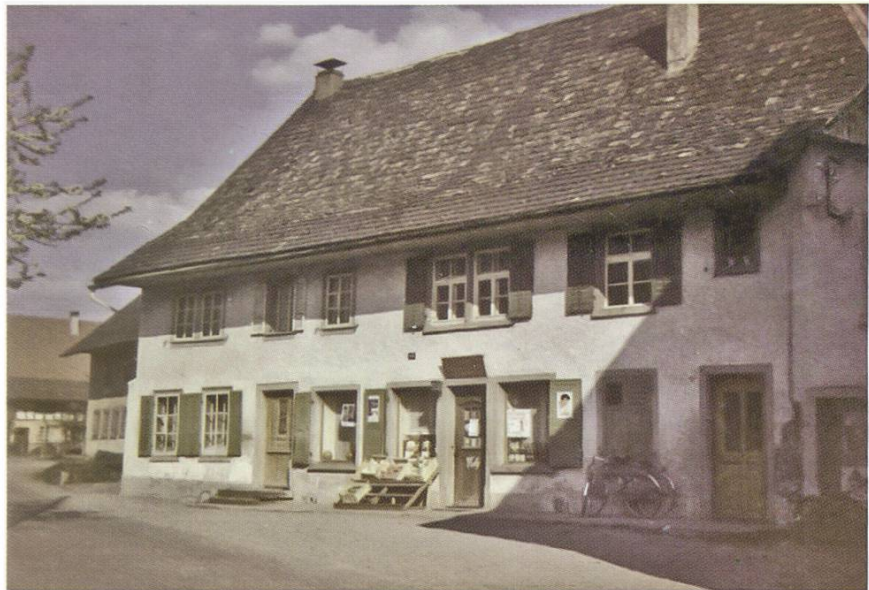
4 Die Konkordia kurz vor dem Abbruch
