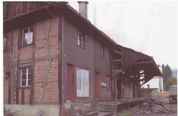
9 Abbruch der Landi 2008 an der Bahnhofstrasse
