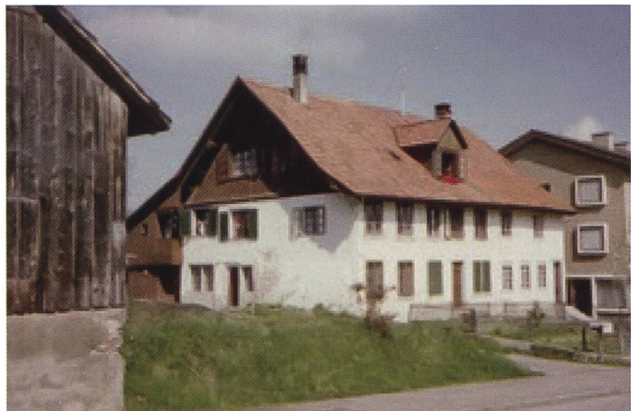
3 Das Haus der ehemaligen Handlung Stüssi kurz vor dem Abbruch 1988
