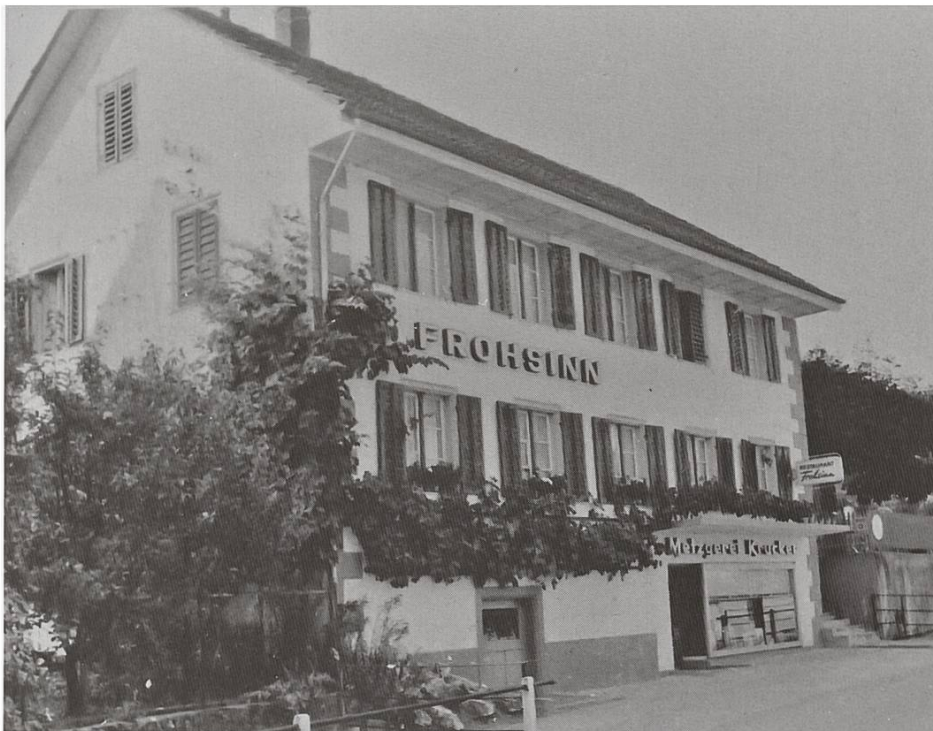
16 Der Umbau des Kellers in eine Metzgerei erfolgte 1960
