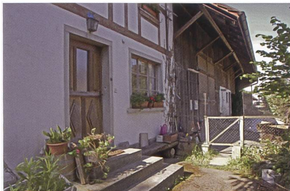
1 Der ehemalige Eingang zum Laden an der Poststrasse 7
