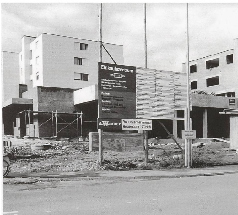
4 Bau des Selbstbedienungsladens mit Metzgerei und Kiosk 1967
