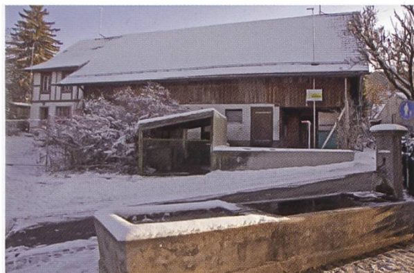
2 Das Bauernhaus kurz vor dem Abbruch im Jahr 2011
