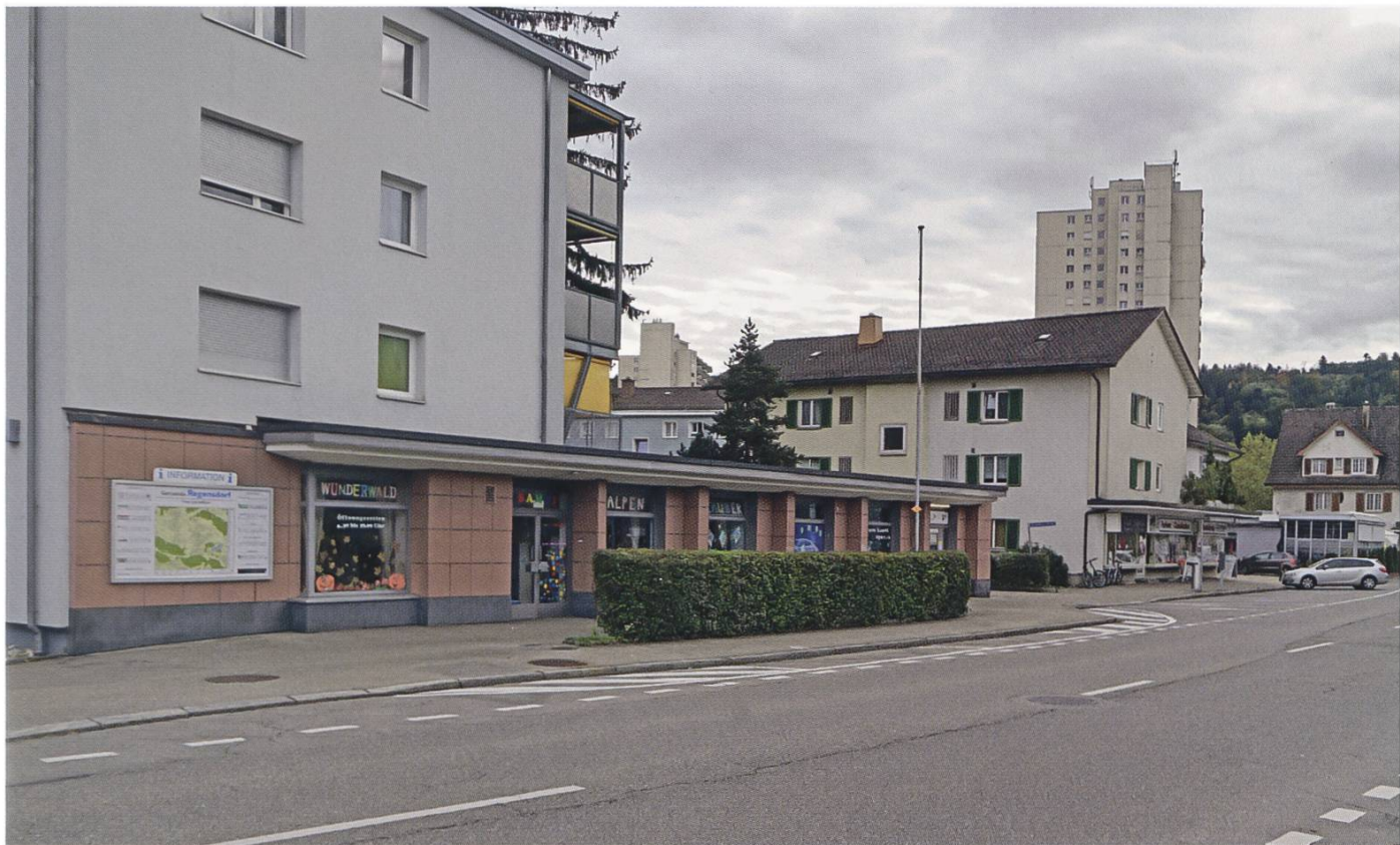
5 Die Migros eröffnet 1958 die erste Filiale in Regensdorf an der Watterstrasse 100
