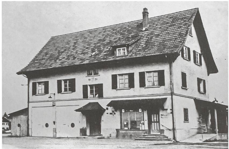
19 Die zweite Milchsammelstelle an der Watterstrasse, unten links das Feuerwehrdepot
