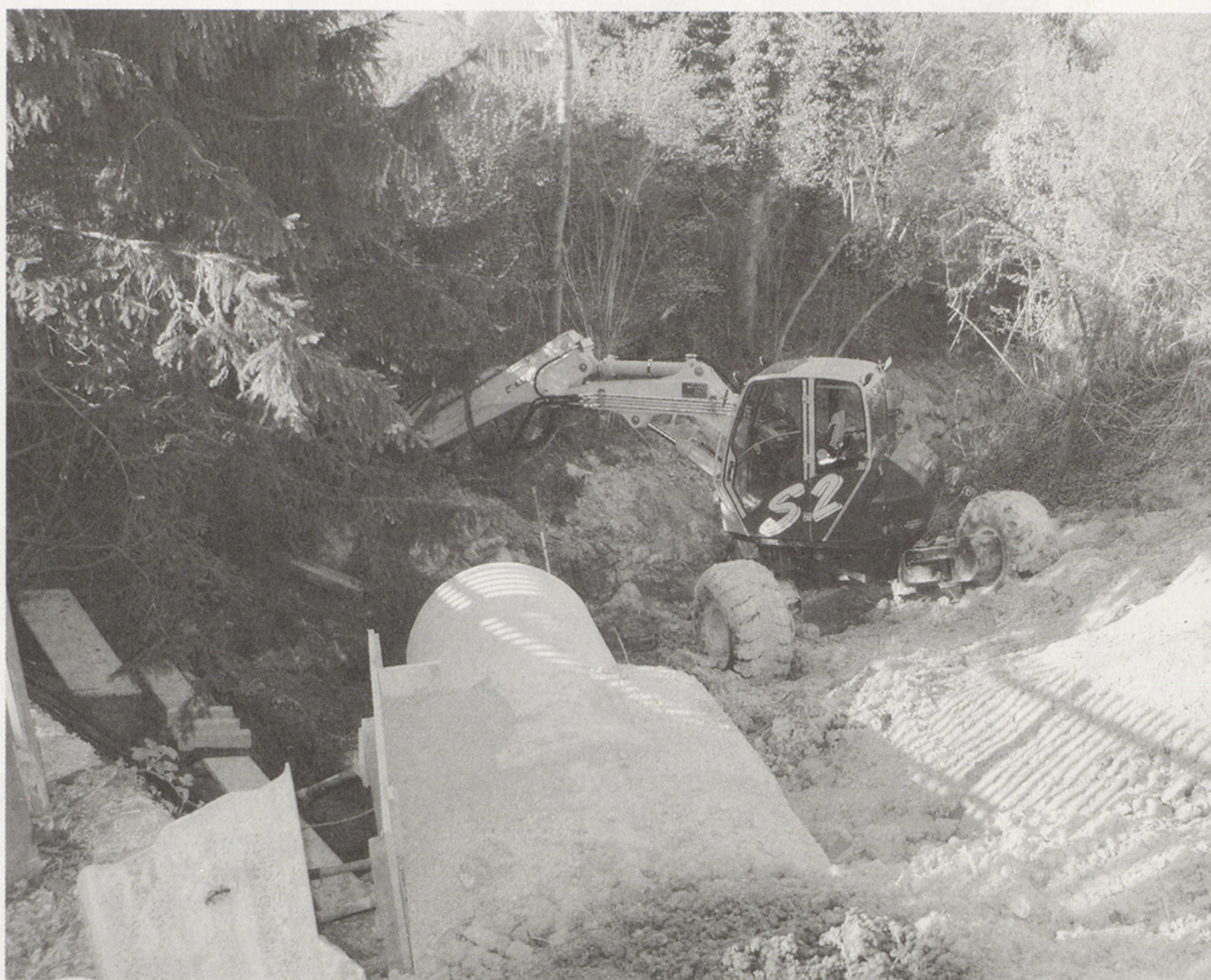
Schwere Geräte waren nötig, um den Bach zu sanieren. (Foto: sl)
