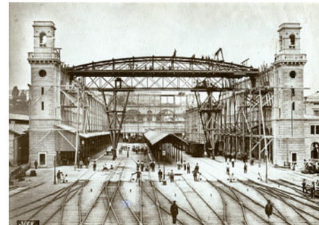
Der neue Hauptbahnhof im Bau 1867 (Foto: BAZ_098164)
