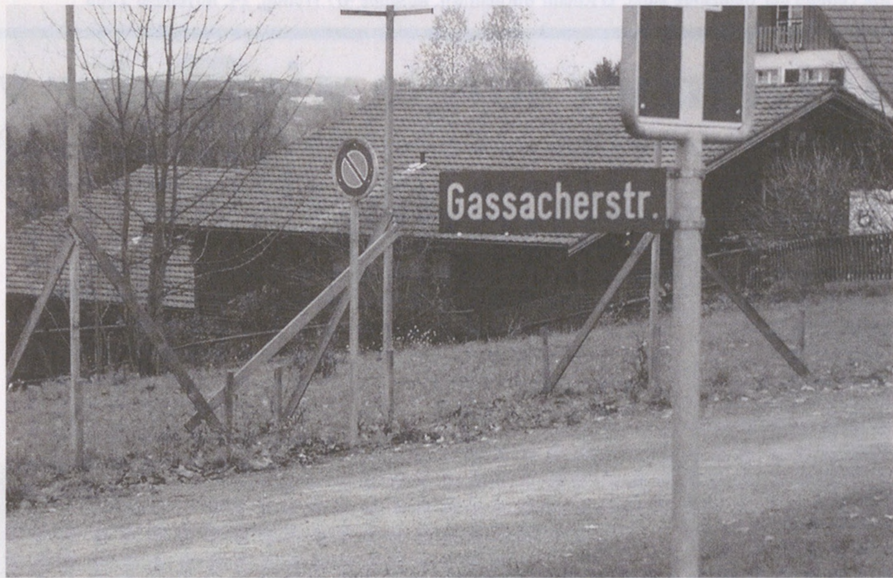
Baugespanne an der Gassacherstrasse – zukünftiges Blockhausprovisorium «Lothar 2000»?
