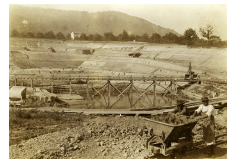
Einstige Lehmgrube in der Binz, Aushub für die Backsteinproduktion (Bild: BAZ_096626)
