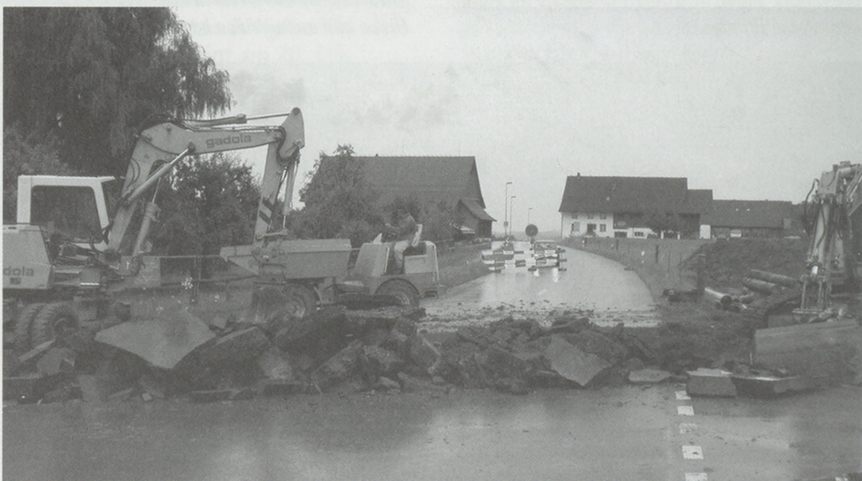
Bis zum 20. Juli noch bleibt die Rellikonstrasse zwischen Maur und Üessikon wegen den Arbeiten am Islanbach gesperrt. Die Umleitung führt über Egg und Aesch. (Foto: kim)
