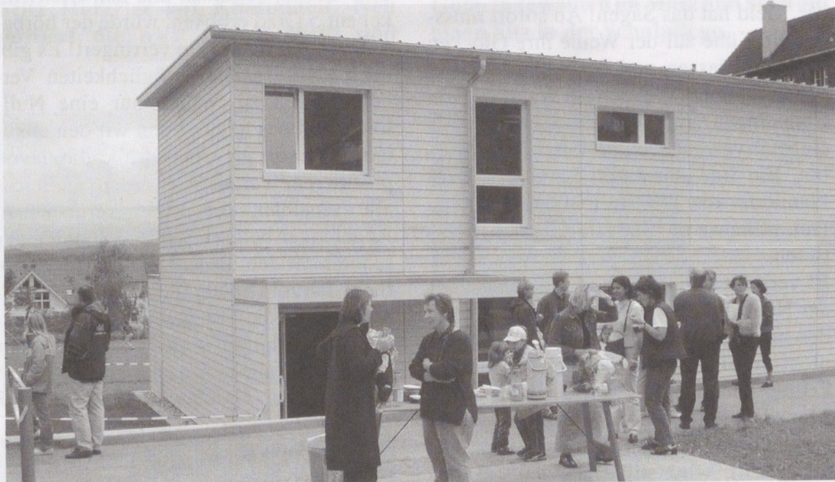
Die Fassade des Schulpavillons Pünt besteht aus einer weissen Holzverkleidung, das leicht geneigte Pultdach aus «Swiss-Panelblech». (Fotos: kim)
