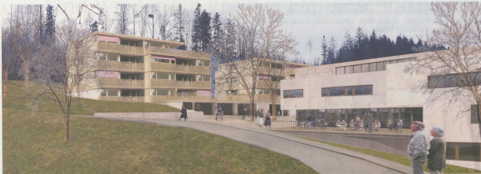
Heute noch eine Baustelle, so soll es künftig aber mal aussehen.
