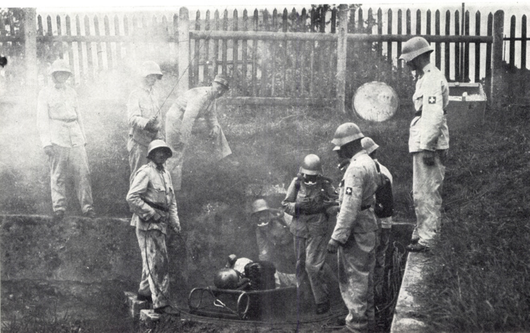
Kreislauf- und Rettungsübungen im Schlammsammler an der Birchlenstrasse.
