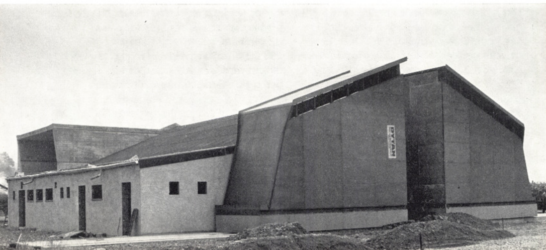
Schalldichte Bremszelle am Rand des Flugplatzes
