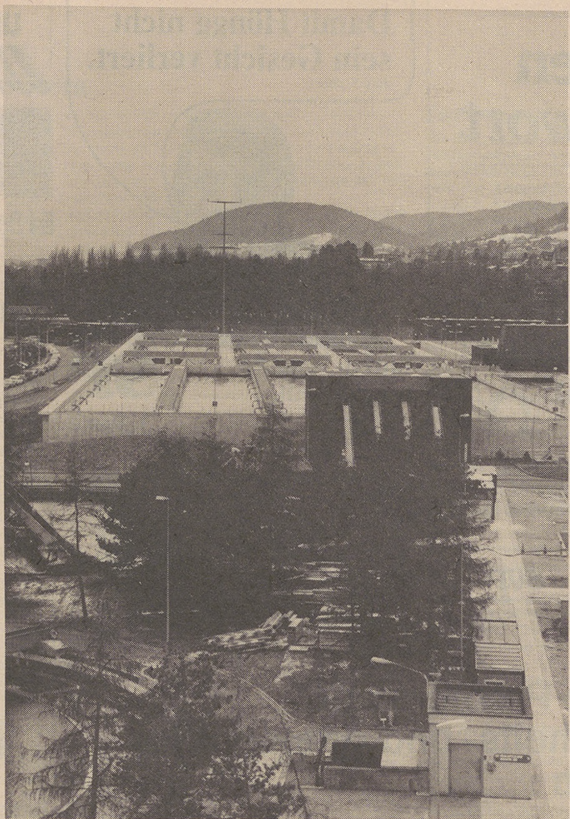
Mehrere Nachklärbecken: biologische Hauptstufe mit Hebewerk
