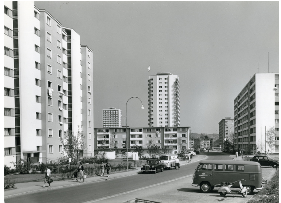
Neubauquartier der 1950er-Jahre an der Hirzenbachstrasse (Bild: BAZ_133293, Carl Häussler)
