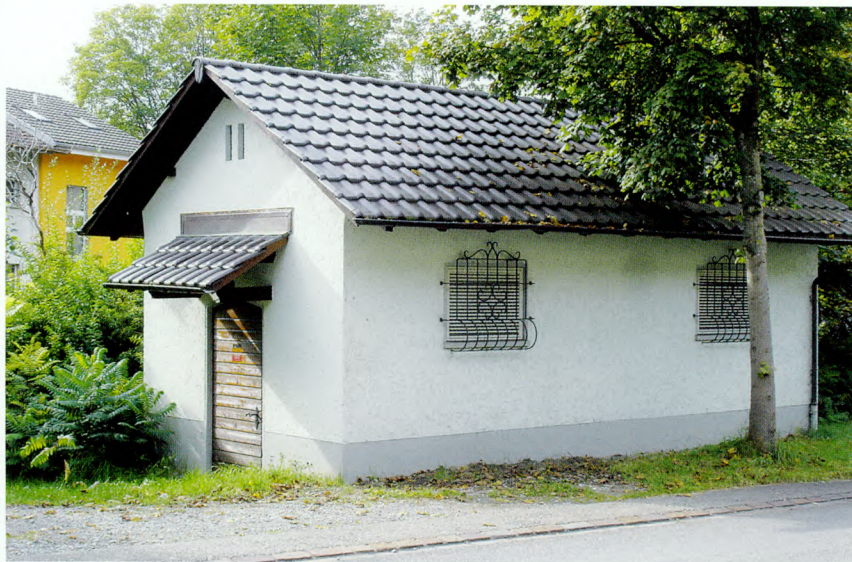
In diesem Gebäude beim Illnauer Rössli-Kreisel war bis 1997 die Messstation und ein Transformator des EWI untergebracht.
