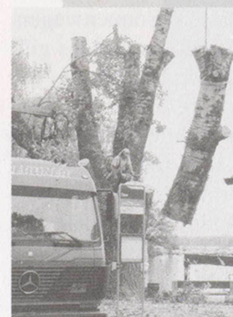
Der Platz an der Schiffflände wird neu gestaltet.
