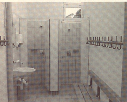
neue Garderoben und Duschen FZA
