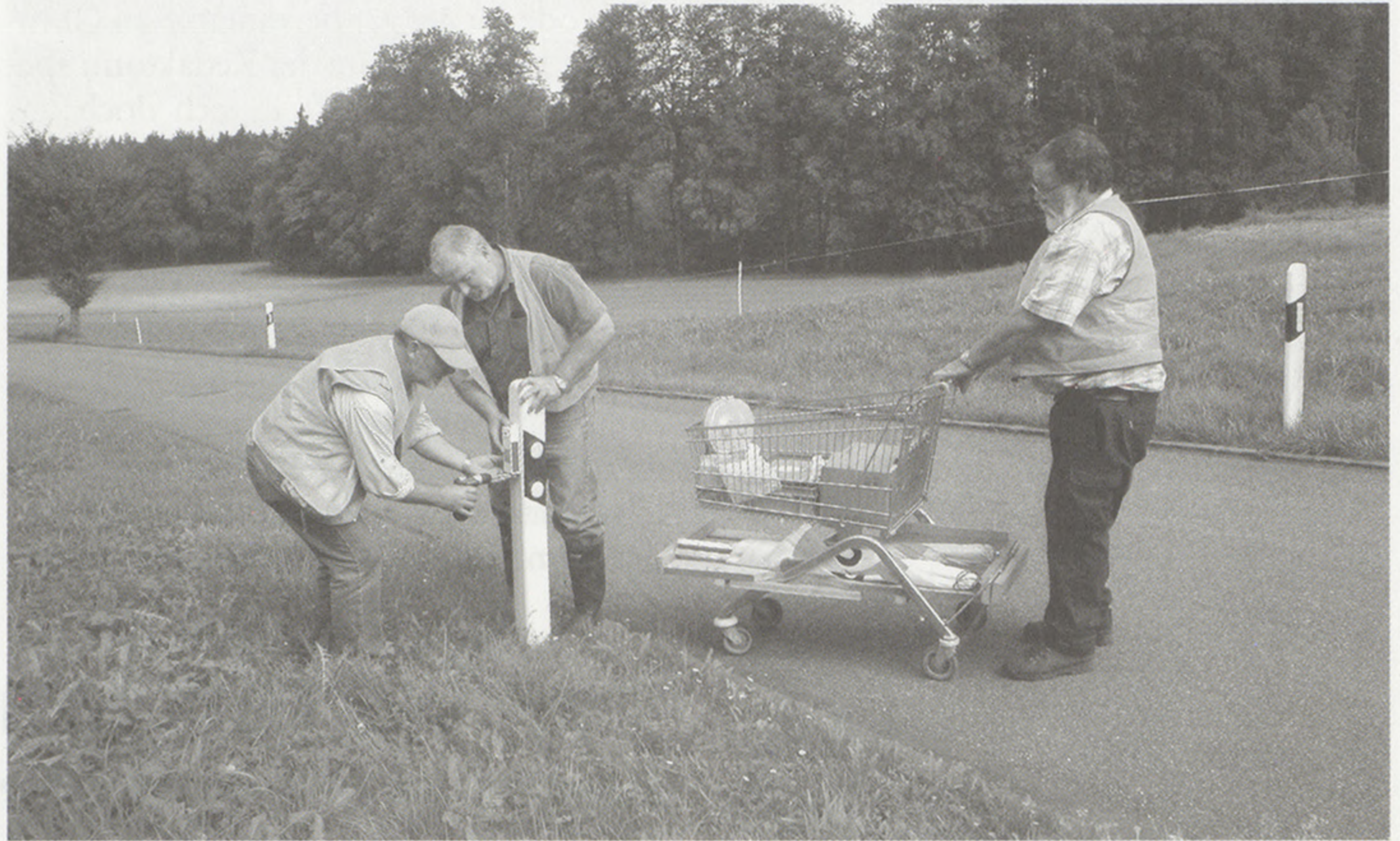
Hansruedi und Reinhard Brüngger sowie Ruedi Muggler (von links) beim Anbringen der Wildwarngeräte an der Eggstrasse. (Fotos: gw)
