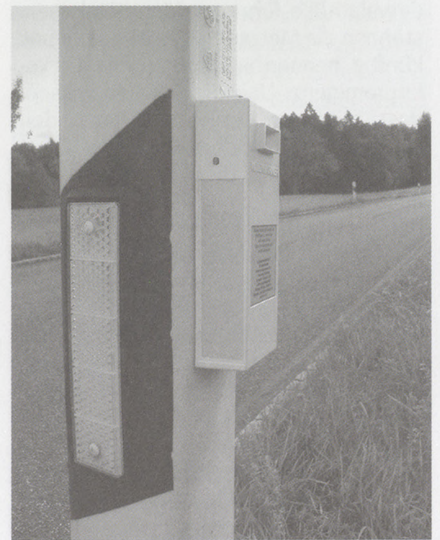
Der für Wildtiere abschreckende Pfeifton erklingt während drei Sekunden, nachdem die Sensoren vom Scheinwerferlicht getroffen wurden. Er ist auch für Menschen hörbar.
