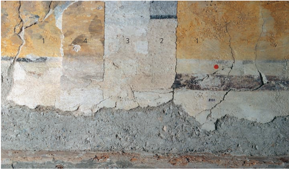
Belegfeld mit Schichtenfolge vor der Ergänzung des Deckputzes. Bereich des Rahmenwerks an der Schiff Südwand, oberhalb des Fenstersturzes: 1) spätgotisches Rahmenband, 2) reformationszeitliche Architektureinfassung mit schwarzer Begleitlinie, 3) graue Architektureinfassung von 1624 ohne schwarze Begleitlinie, 4) Rahmenband von 1890/91 mit Schablonenmuster. Aufnahme 1995. Vgl. Abb. unten.
