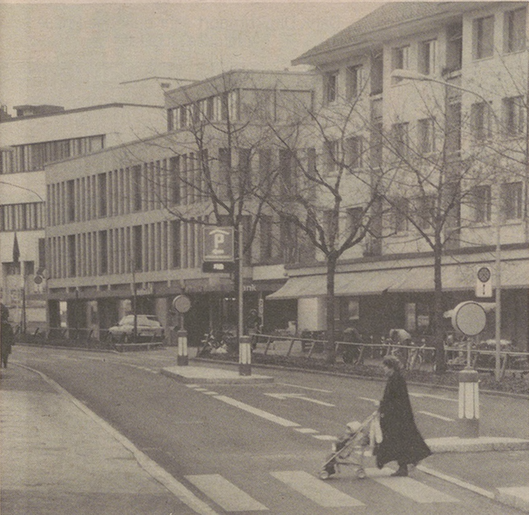
Der Kantonalbank-Neubau ordnet sich recht gut in die Regensdorferstrasse ein. Einerseits farblich durch die Fassadenverkleidung im hellbraunen Naturstein Trachit. Andererseits wirkt der kubische Baukörper trotzdem elegant durch den Anteil und die Proportion der schmalen, hohen Fensterflächen.
