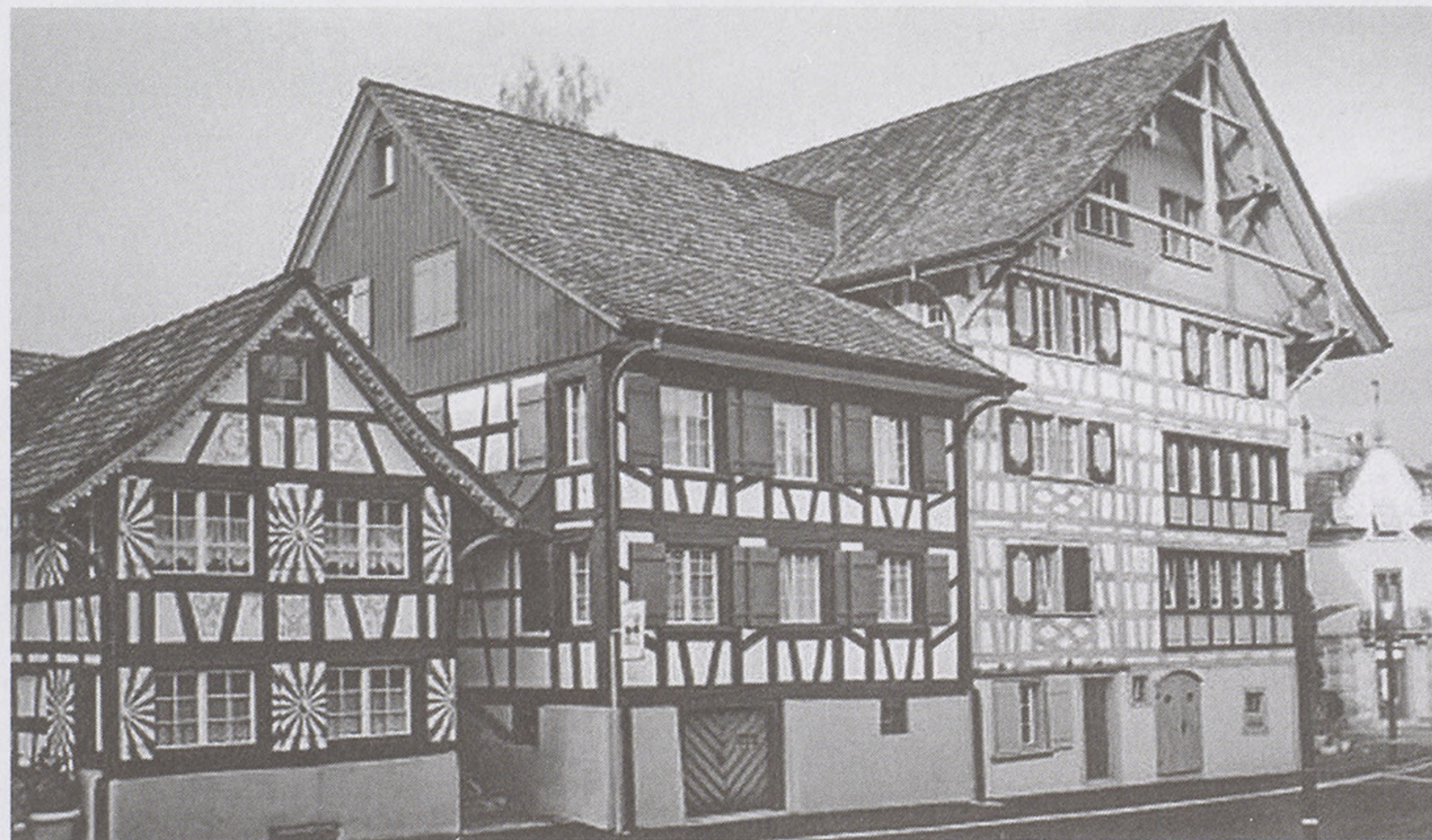
Ein prächtiges Ensemble aus drei Fachwerkhäusern: Haus zur Farb 1769 (ehem. Färberei), Frauenfelderstrasse, und Malerhüsi 41 in Weinfielden mit den kunstvoll verzierten «Züri-Vieri». Renovation 1990 durch Architektur Hanspeter Büchel. (Foto: zvg)
