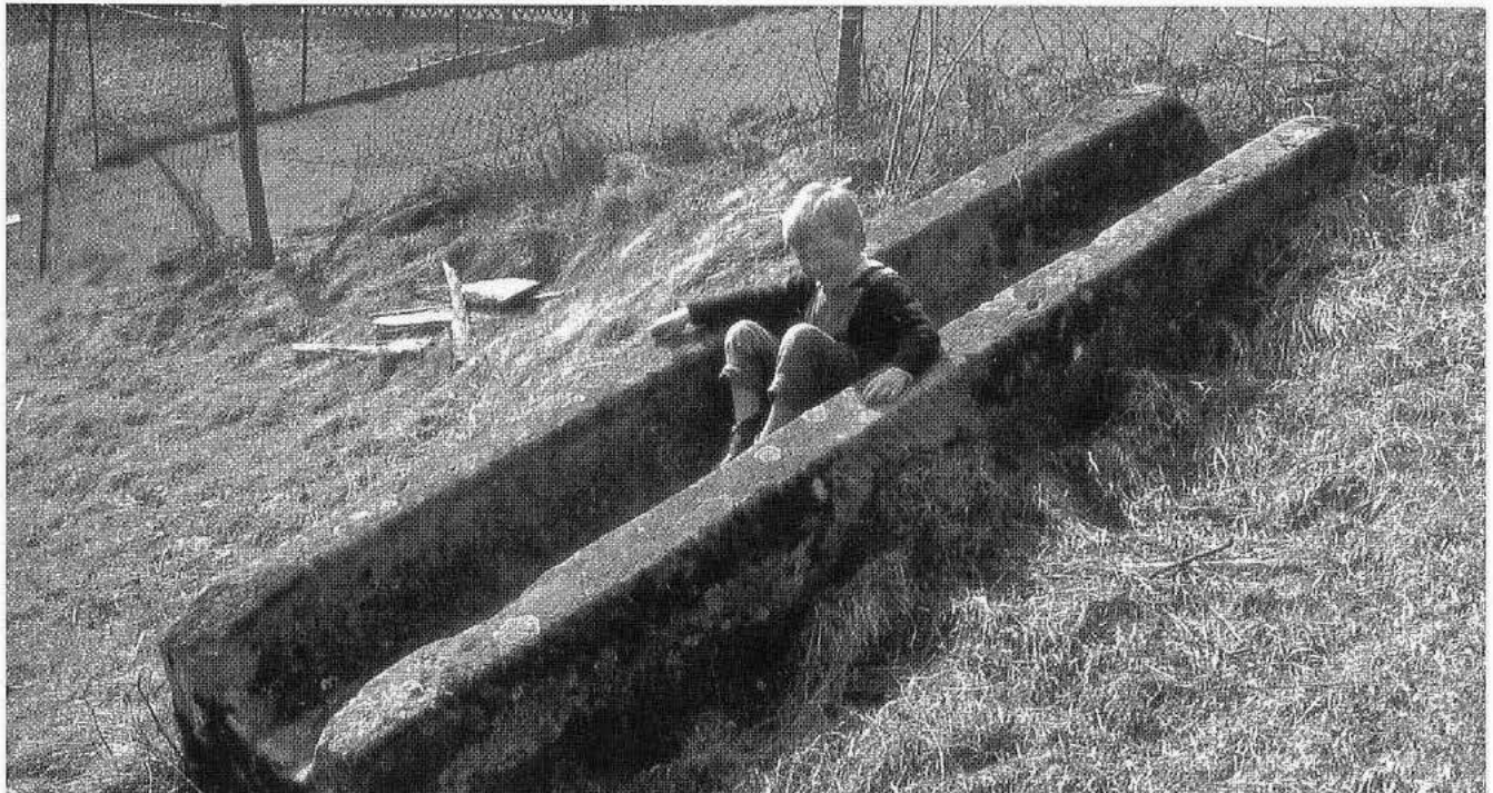
Nebst dem alten Türsturz mit der Jahreszahl 1585 ist das alles, was von der einstigen «Müli» übrig geblieben ist: Ein Stück der offenen, steinernen Wasserzuleitung aus dem (unteren) Müliweiher an der Ecke Uitikoner-/Kampstrasse.
