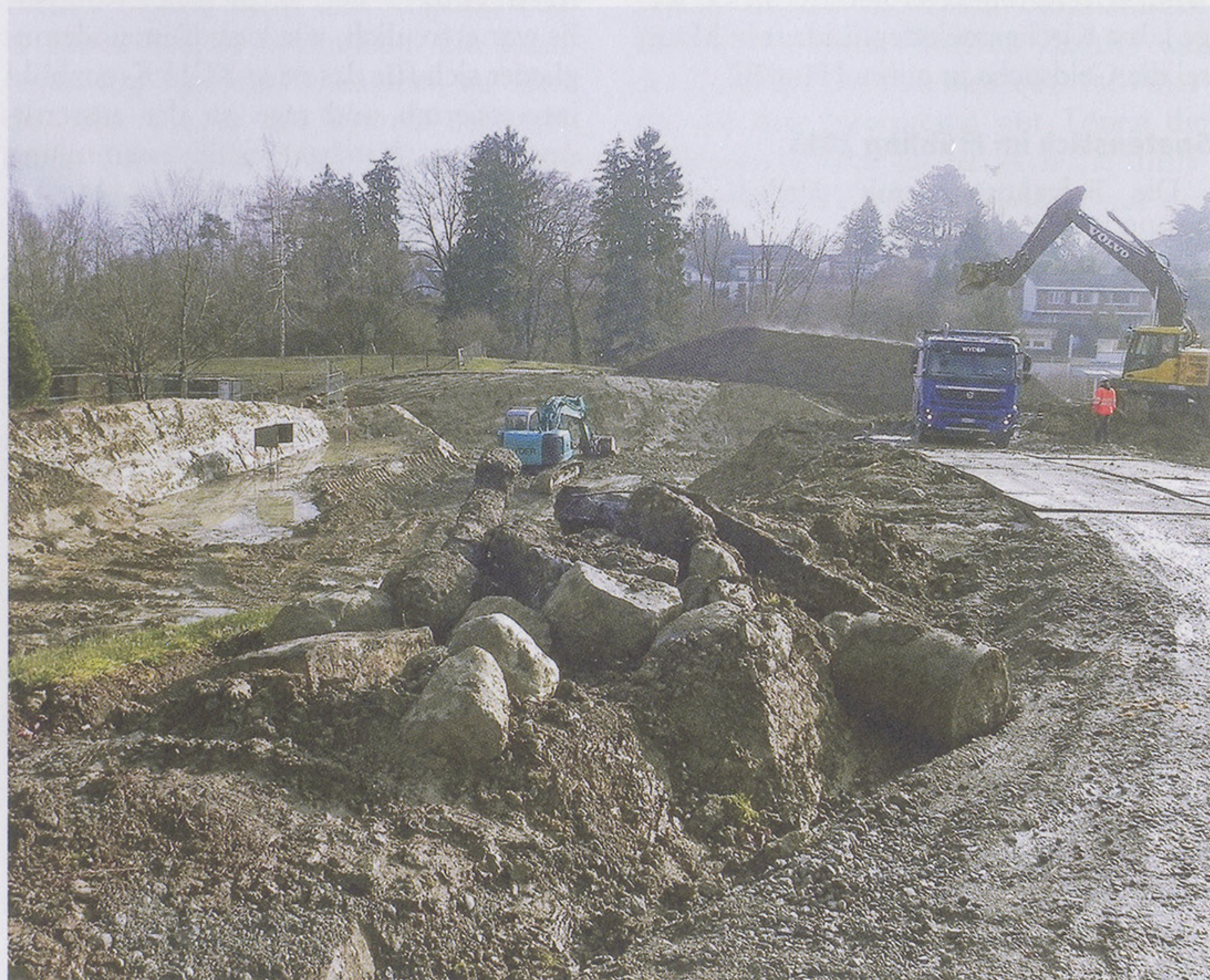
Das Zollingerheim ist aktuell die grösste Baustelle in Maur – an der Gemeindeversammlung wurde das Darlehen für den Bau der Seniorenwohnungen genehmigt. (Foto: cl)
