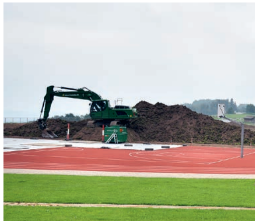
Der Fussballplatz: ein grosser Erdhaufen.
