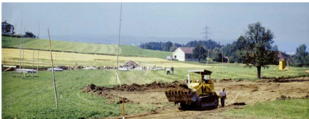
Baubeginn Looren im Spätsommer 1964 mit Blick nach Norden.
