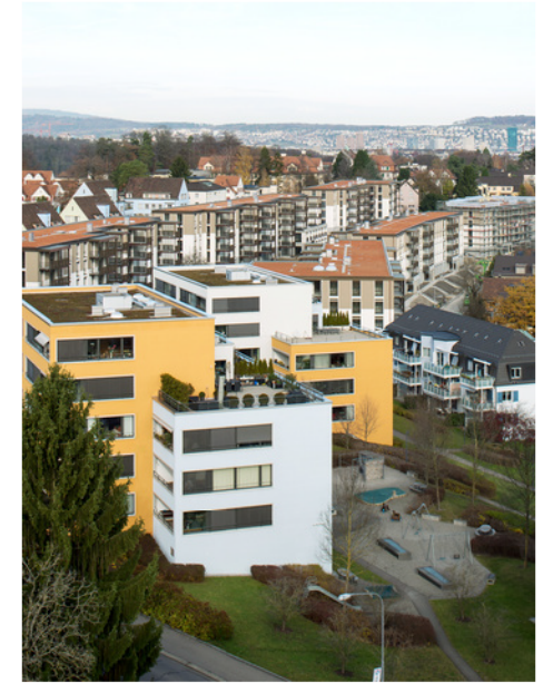
Aktuelle Ersatzneubauten der ABZ auf dem Entlisberg (Bild: HAL_005229, Juliet Haller)
