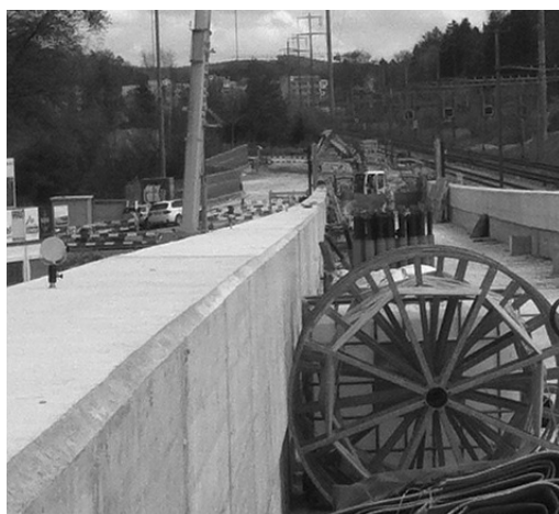
Die aktuelle Baustelle „Hürlistein“ in Tagelswangen, welche demnächst nahtlos durch jene für den Bau eines 4. Gleises abgelöst wird.
