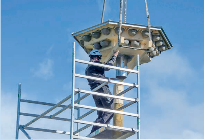
Montage des neuen Vogelhotels in luftigen Höhen (Foto: zVg)
