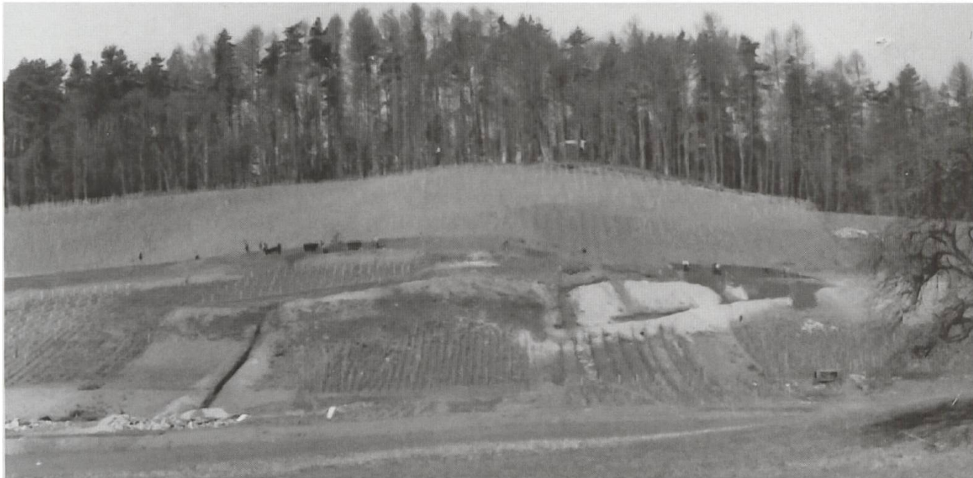
77 Otelfingen, Rebberg Ghei, während der Melioration 1935. Deutlich sichtbar die mit einer Drainage sanierte Rutschstelle rechts der Bildmitte
