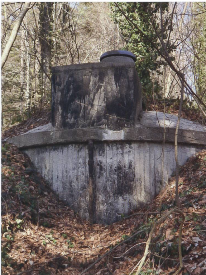
80 Otelfingen, Wasserreservoir von 1935 im Fältschenmaas, heutiger Zustand
