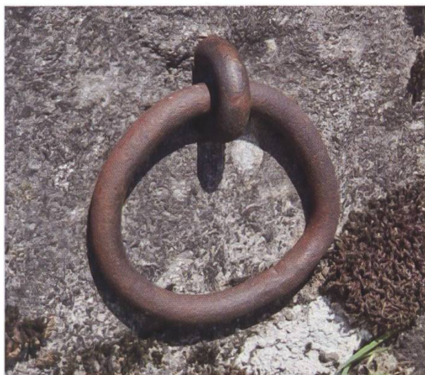
73 Otelfingen, Ring für Umlenkrolle an Stützmauer Ellenbergstrasse von 1935
