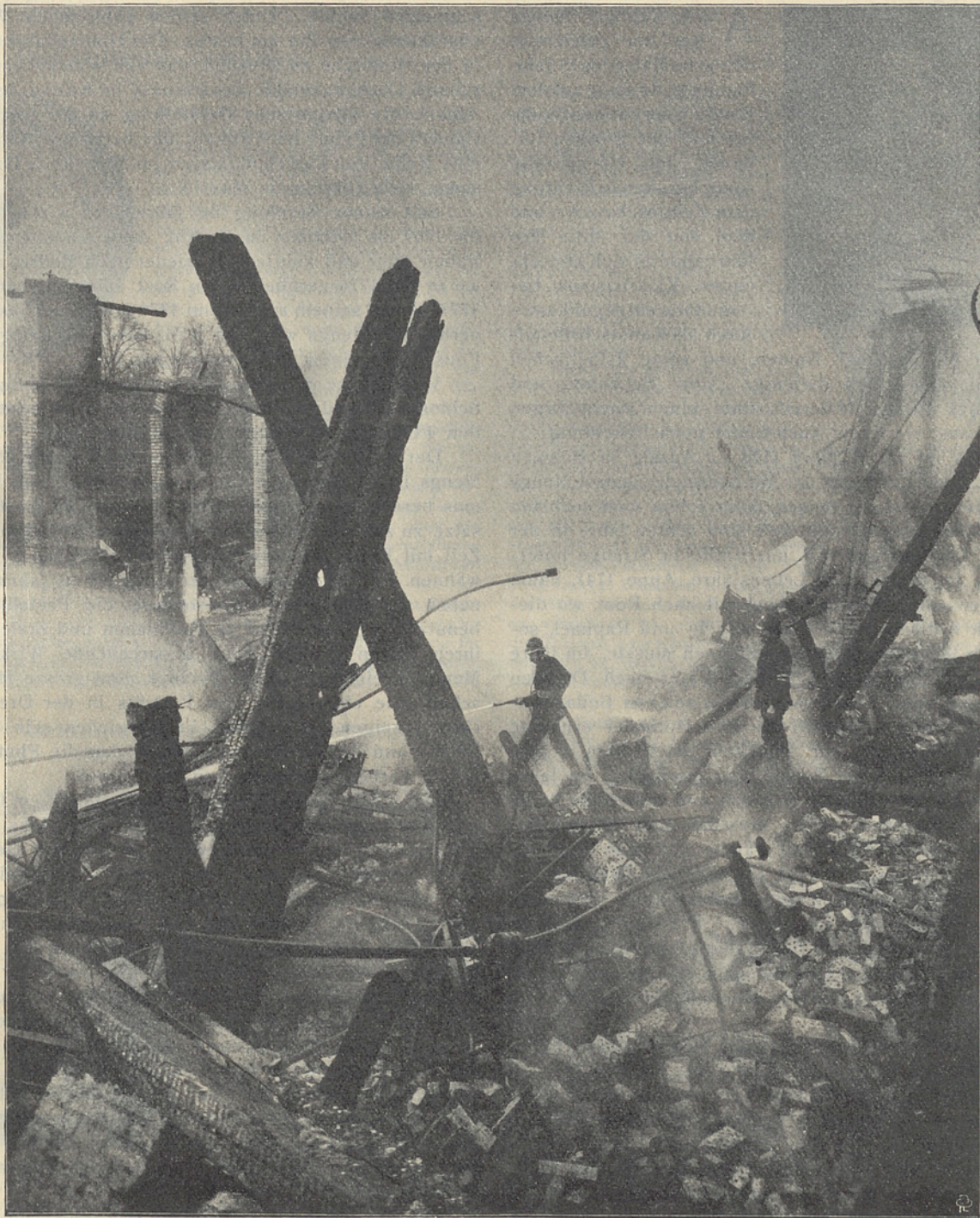
Die Ruine der abgebrannten alten Neumühle in Zürich.
