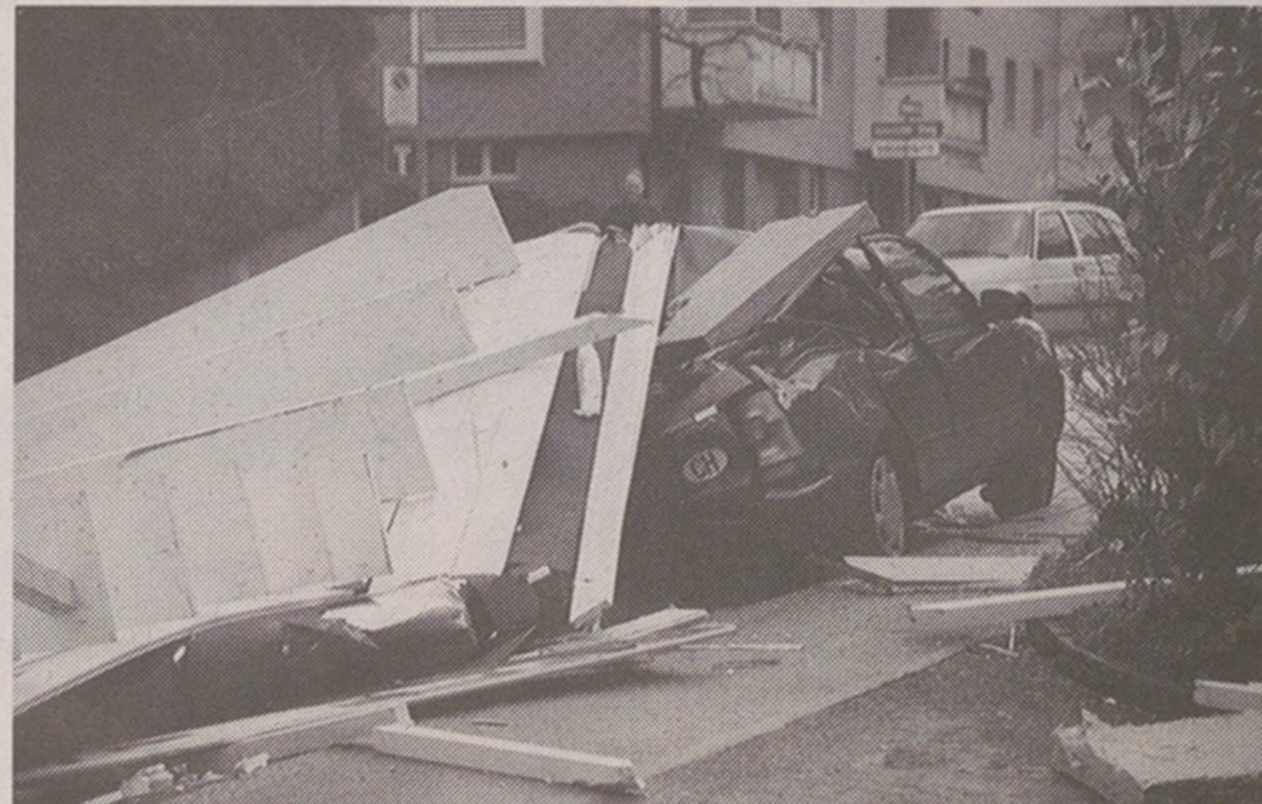
Wohl eher erschrocken reagierten die Hausbewohner im obersten Geschoss an der Imbisbühlstrasse, Höhe Imbisbühlsteig, als eine Sturmböe das massive Kupferdach abhob und in der Strasse ein Auto erdrückte. Ein grosses Glück, dass niemand zu Fuss unterwegs war! Foto Rudolf Th. Gloor
